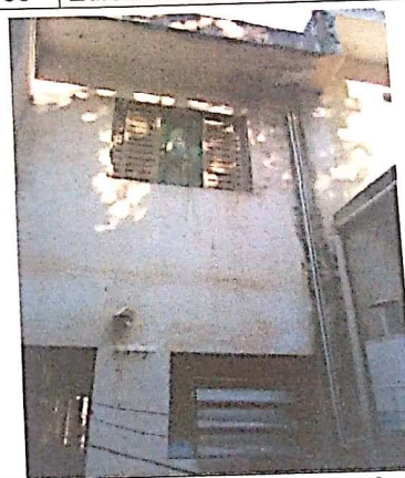
Foto - 10 | Vista da edícula para o fundo do imóvel
