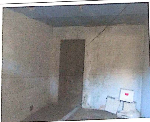
Foto - 11 | Vista do cômodo da edícula
