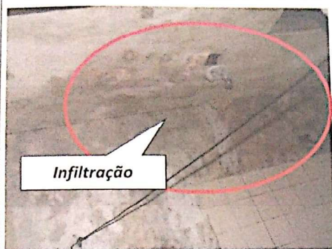
Foto - 19 | Banheiro da edícula
