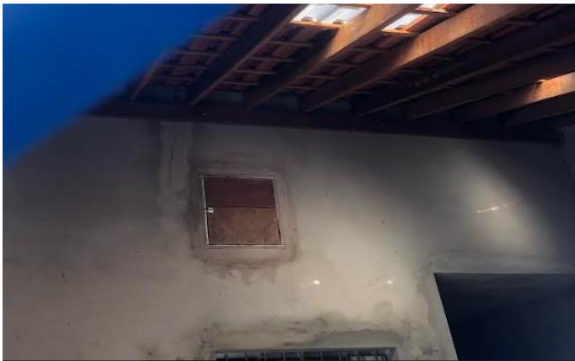
Visão da cobertura da garagem
