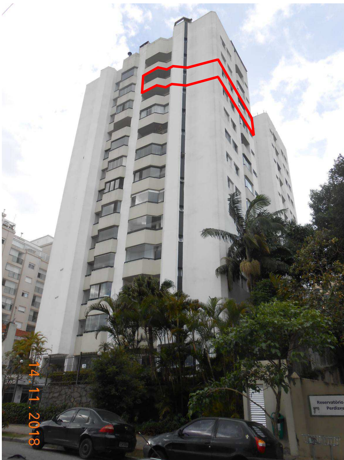
Foto 21: Fachada do Edifício Perdizes Bem Viver com imóvel avaliando indicado em vermelho
