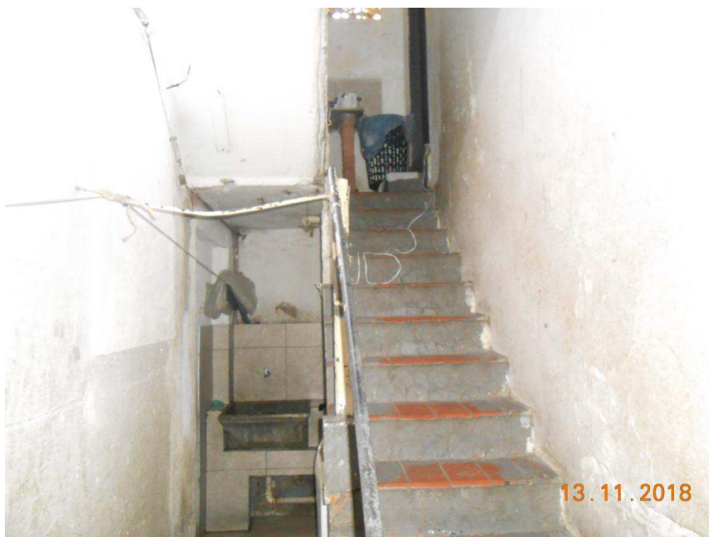
Foto 9: Área de serviço do pavimento inferior
