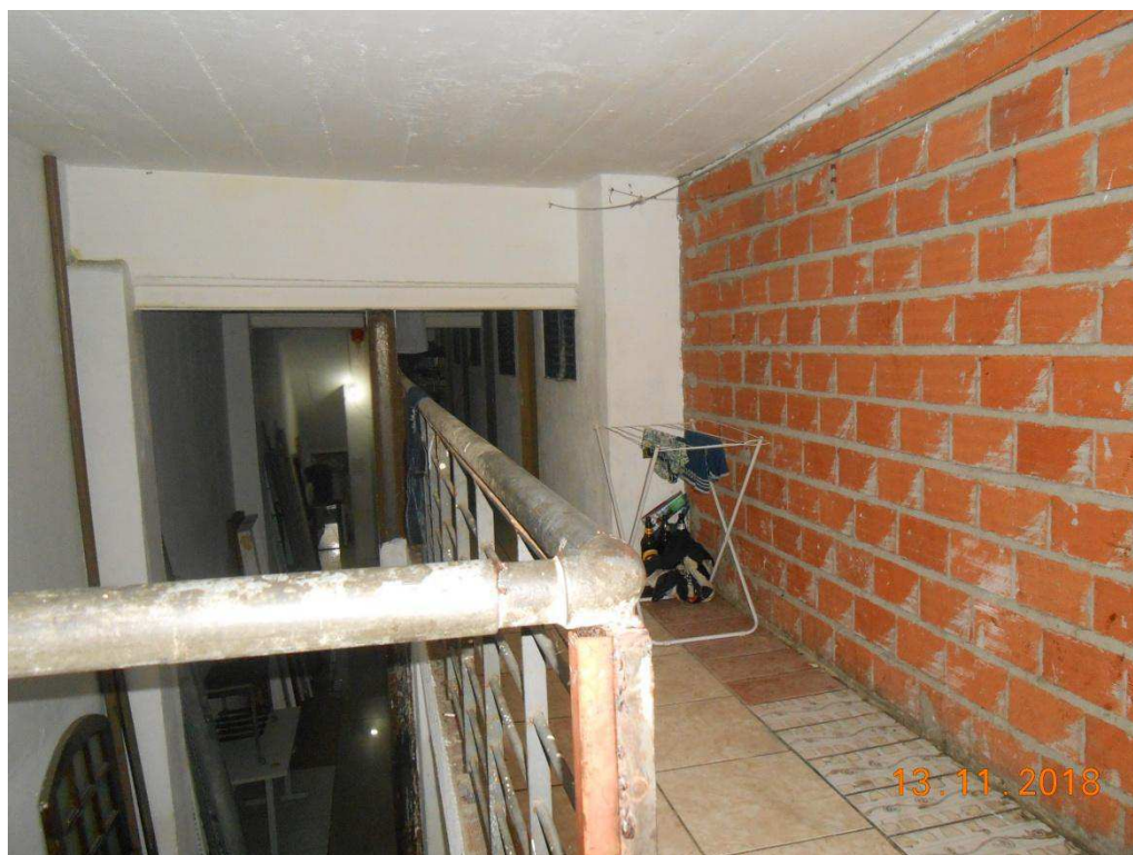
Foto 10: Quartos para locação dentro do galpão – mezanino do pavimento inferior
