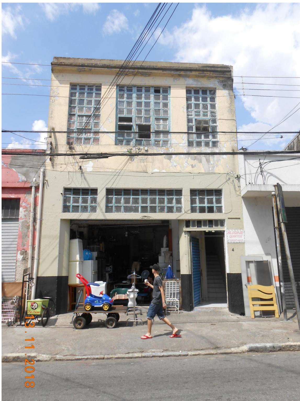
Foto 2: Fachada do imóvel
