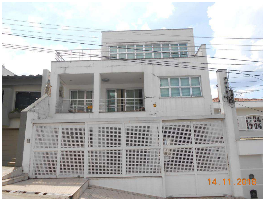
Foto 2: Fachada do imóvel
