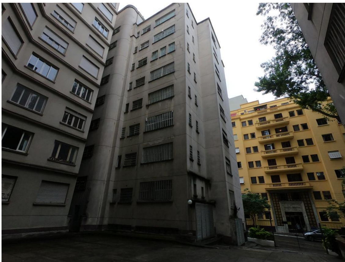
Figura 9. Edifício América do Sul.
