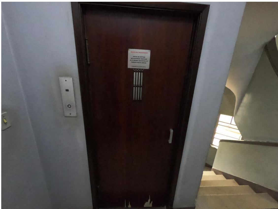
Figura 144. Porta do elevador.
