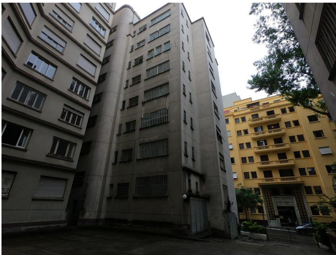
Figura 9. Edifício América do Sul.
