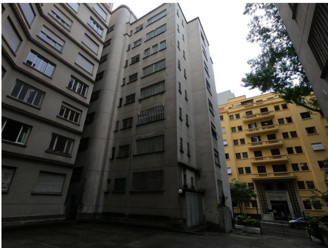
Figura 9. Edifício América do Sul.
