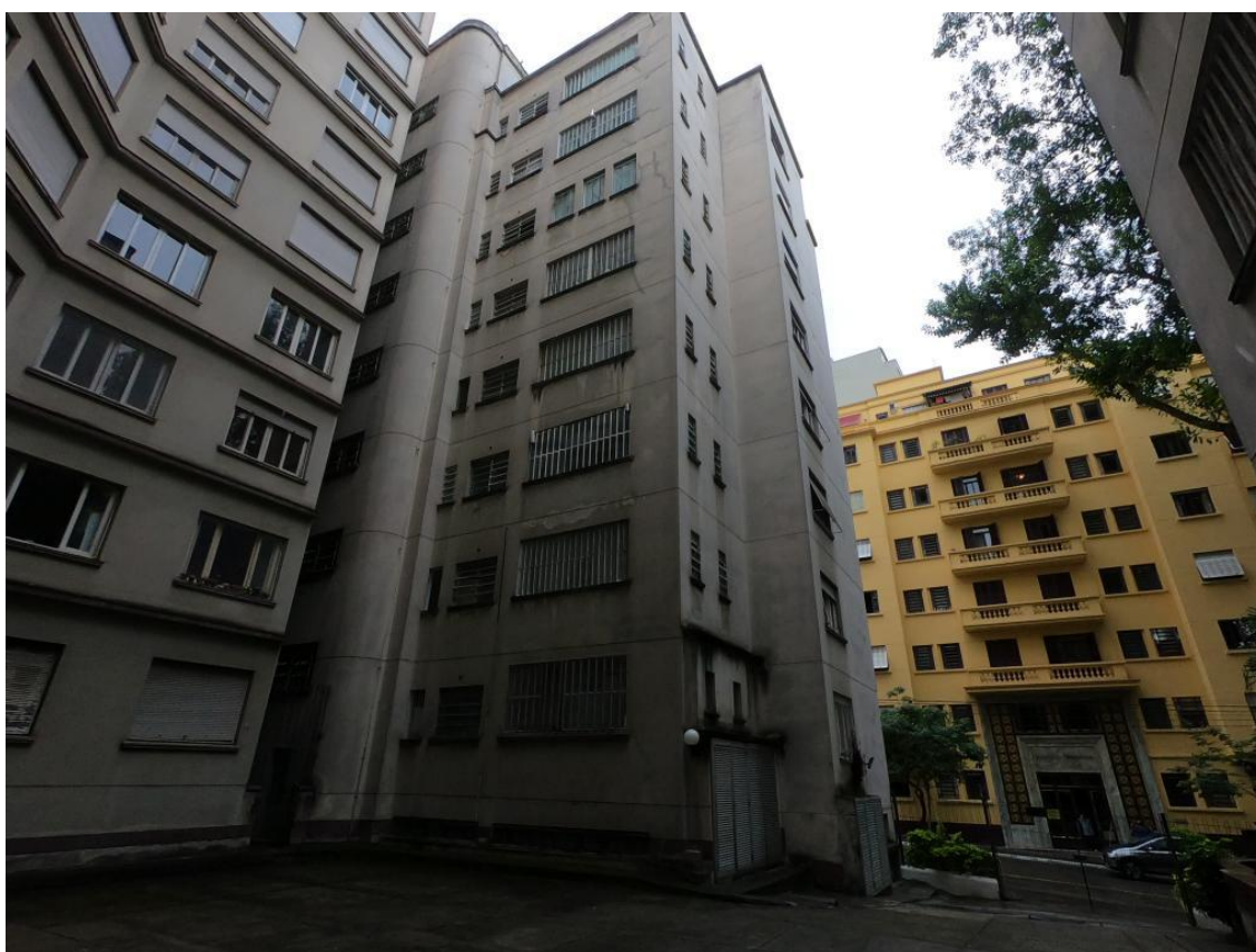
Figura 9. Edifício América do Sul.
