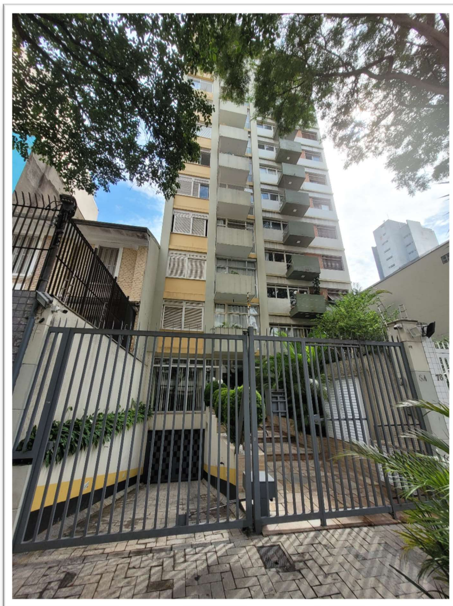
FOTO 01 – FACHADA DE FRENTE DO CONDOMÍNIO
