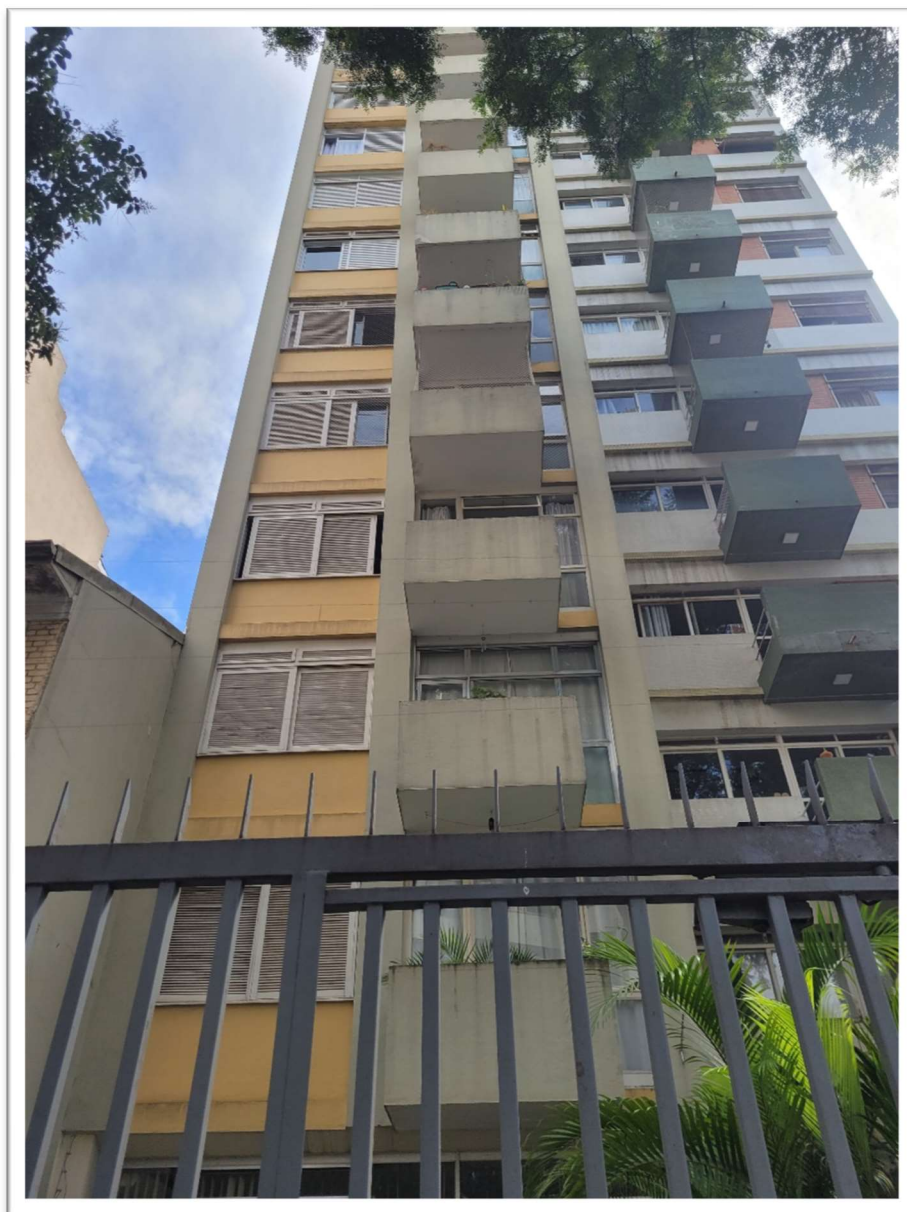
FOTO 02 – DETALHE DA FACHADA FRONTAL DO PRÉDIO
