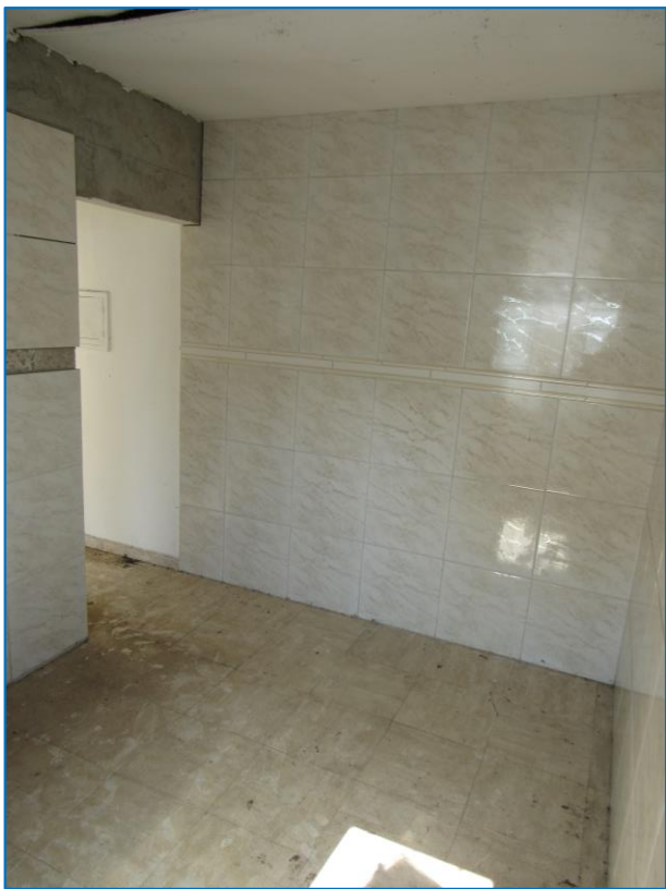
OUTRA VISTA DA COZINHA.
