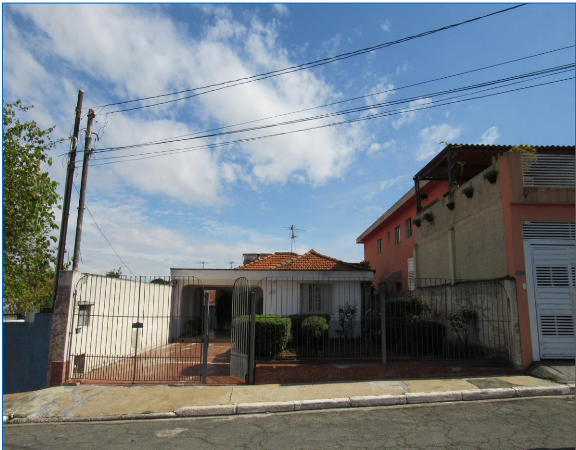
FACHADA DO IMÓVEL AVALIANDO (2).
