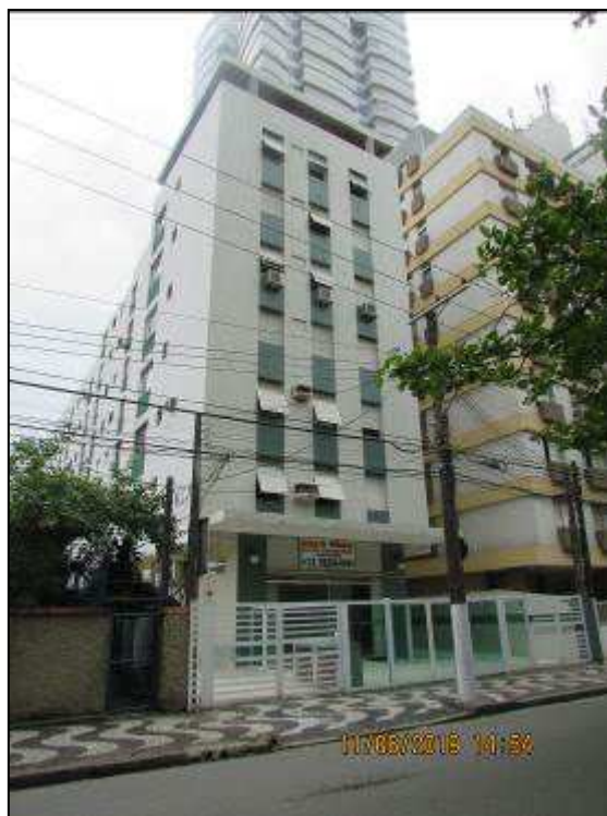
Foto 01 – Fachada frontal do Cond. Edifício Praia Linda.
