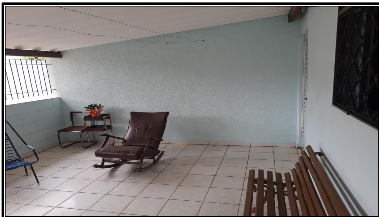
Foto 4 – Vista interna do prédio residencial, onde ilustramos o piso em cerâmica, portas de ferro, com acabamento das paredes em argamassa e em tinta látex.
