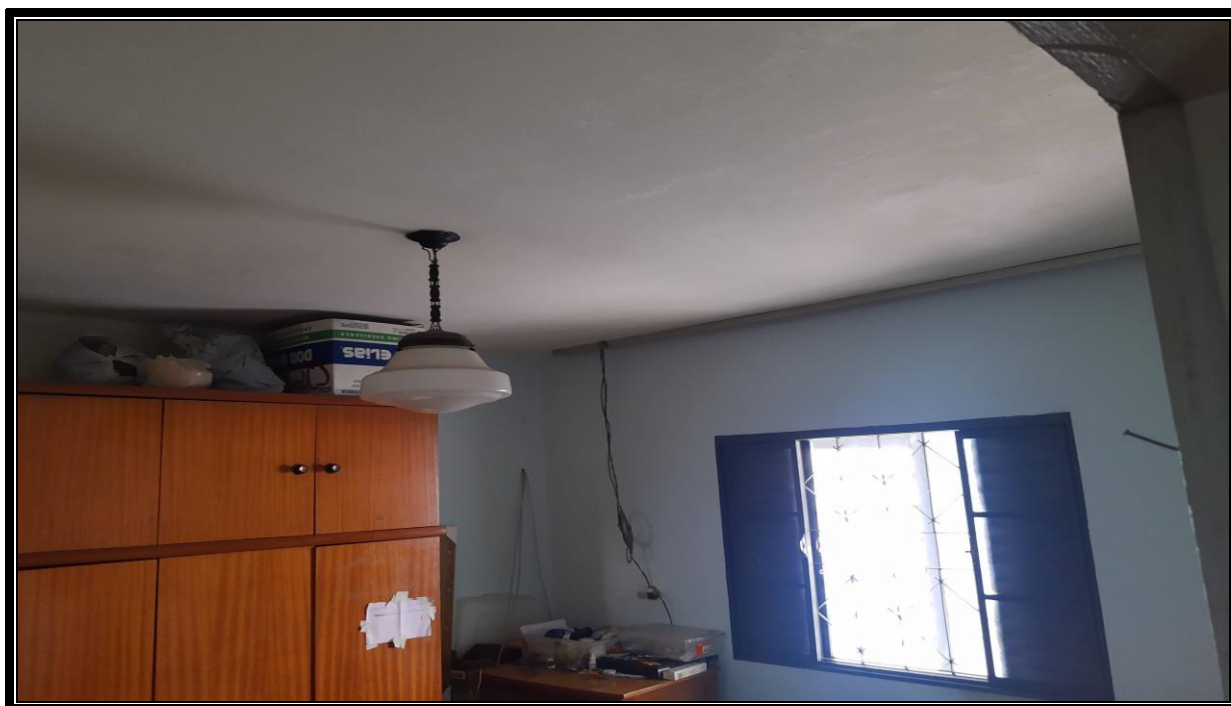
Foto 6 – Vista do interior do dormitório, onde ilustramos o piso em cerâmica, paredes com acabamento em tinta látex, esquadrias de ferro e instalações elétricas embutidas.
