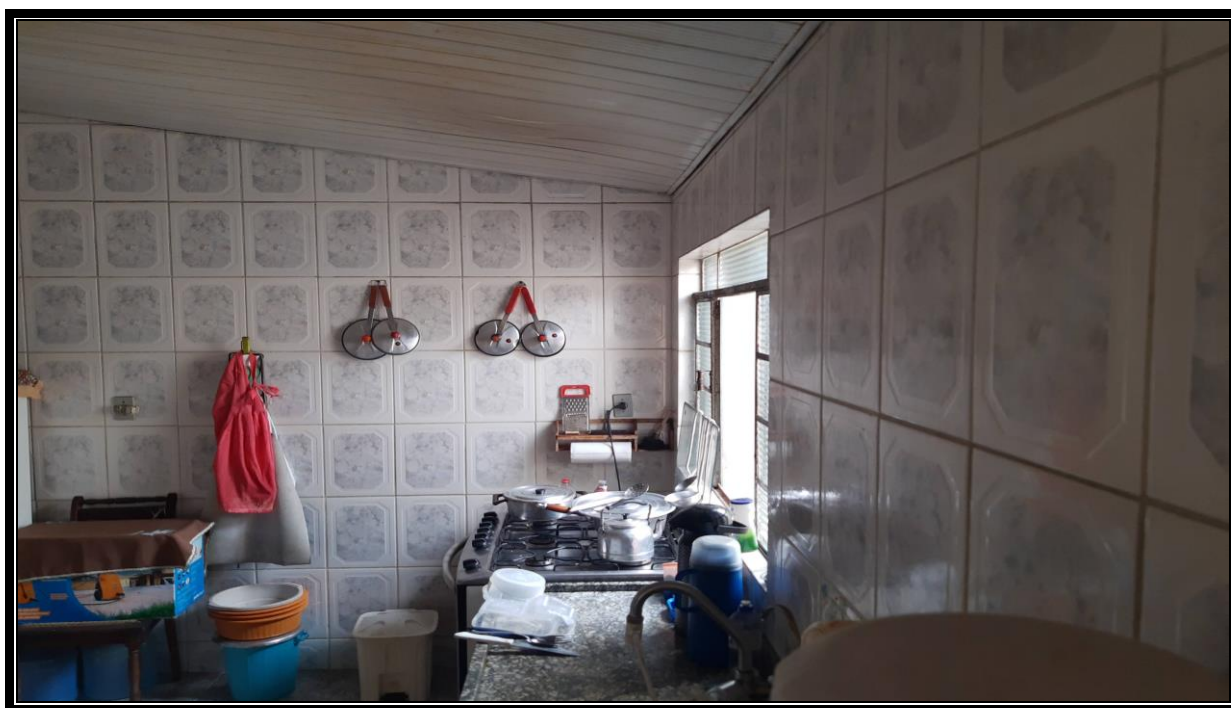
Foto 7 – Vista do interior do prédio onde ilustramos os acabamentos da cozinha, em azulejo até o teto, piso cerâmico, esquadrias de ferro e instalações elétricas e hidráulicas embutidas.
