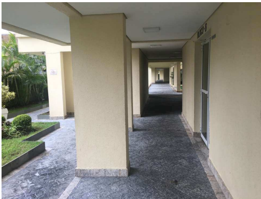
ASPECTOS GERAIS DO EDIFÍCIO
