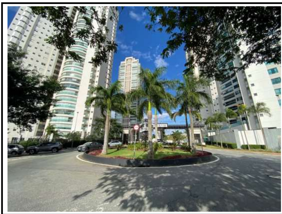
Foto nº 01: Vista da Avenida Parkinson. O observador encontra-se defronte a portaria principal.
