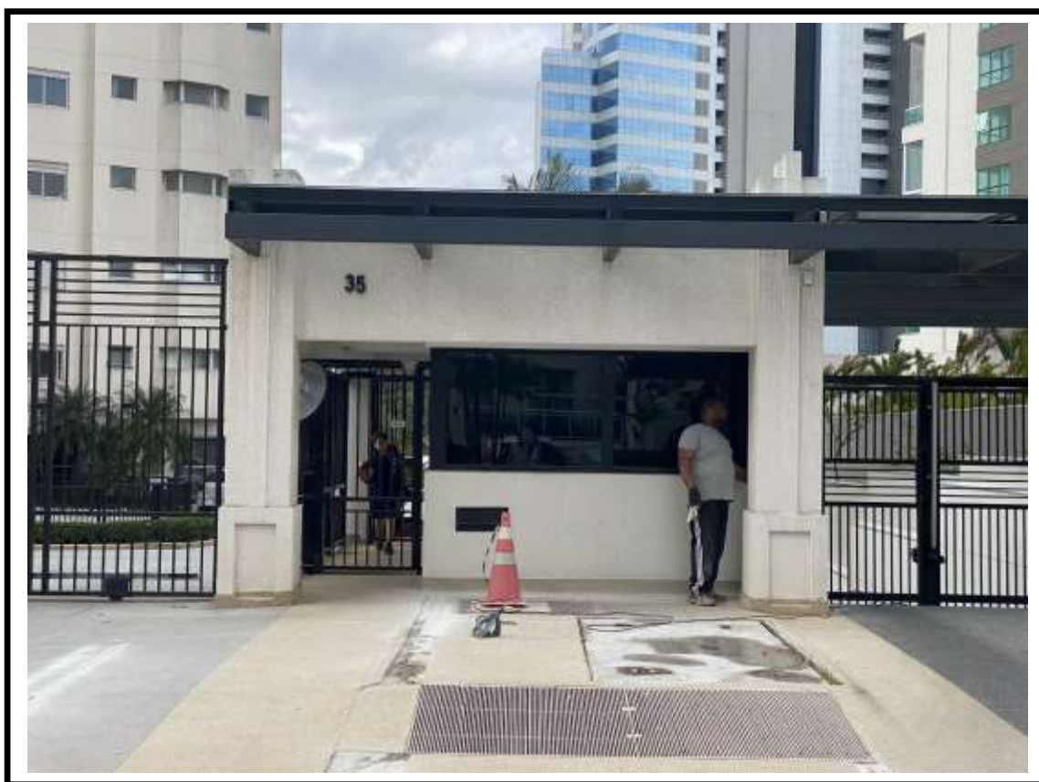
Foto nº 05: Vista da entrada de pedestres.
