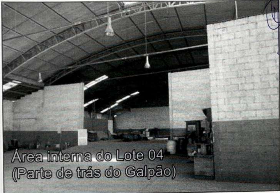
Figura 48: Detalhe interno do Lote 04 – Quadra 32 (Acervo do Perito – 2021).
