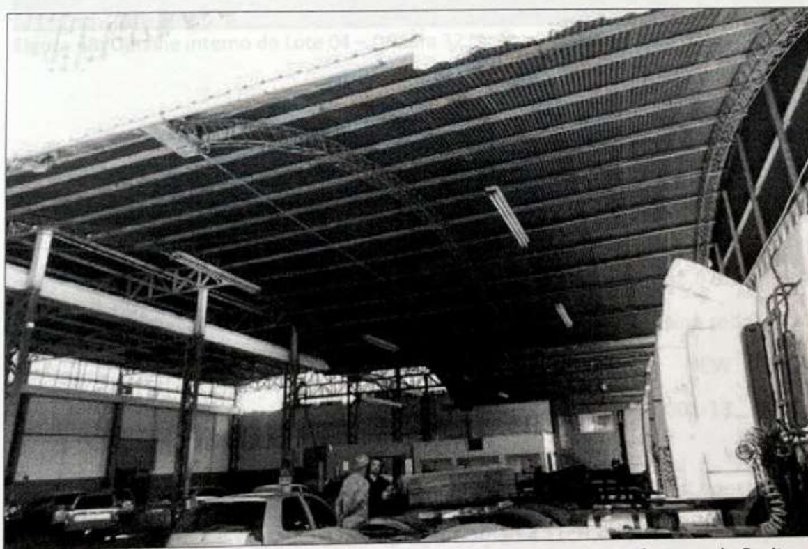
Figura 47: Detalhe da Cobertura dos Lotes 25, 26, 27 e 28 – Quadra 32 (Acervo do Perito – 2021).
