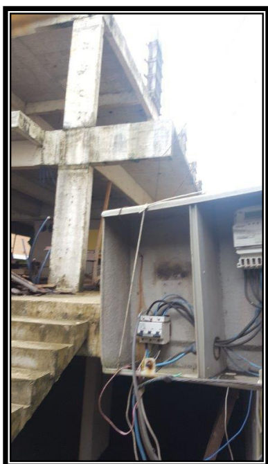
Figura 5 - Vista da Construção
