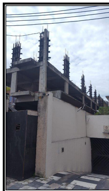
Figura 6 - Vista da Construção
