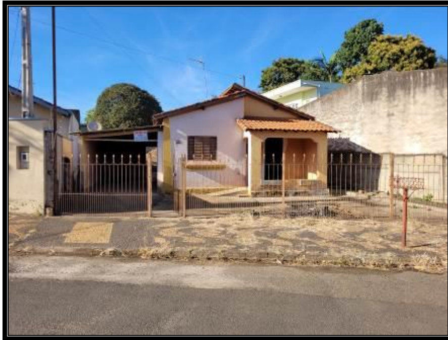
Vista da frente do imóvel avaliando.
