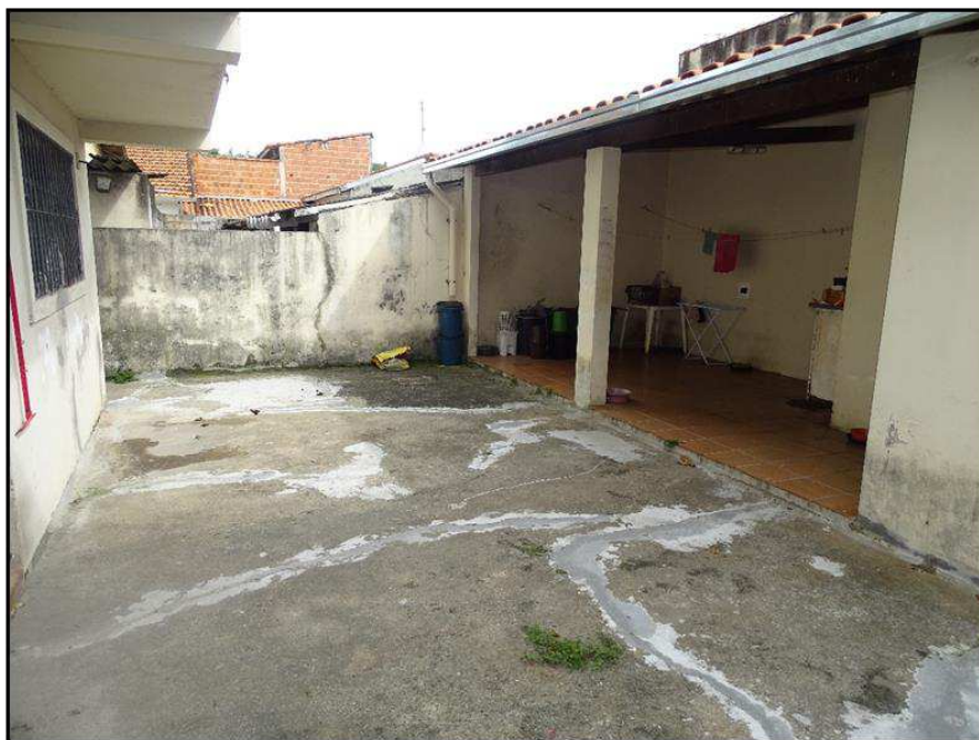
Vista do quintal dos fundos do imóvel avaliando.
