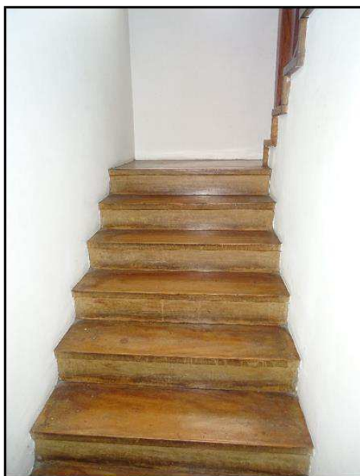
Vista parcial da escada de acesso ao piso superior, do imóvel avaliando.
