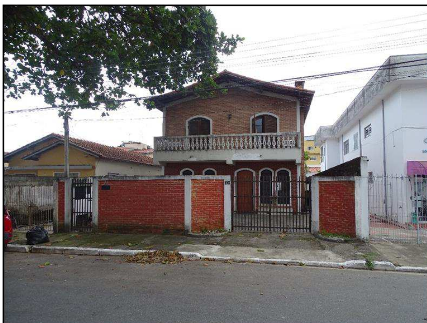
Vista geral da fachada frontal do imóvel avaliando.
