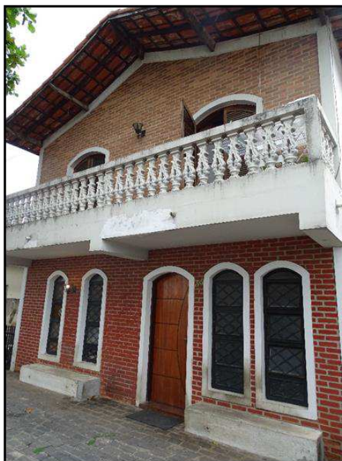
Vista detalhada da fachada frontal do imóvel avaliando.
