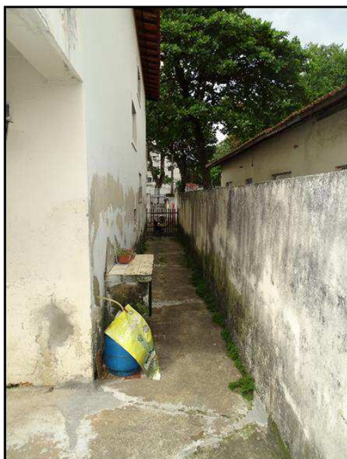
Vista do corredor lateral externo esquerdo de quem da rua olha, do imóvel avaliando.
