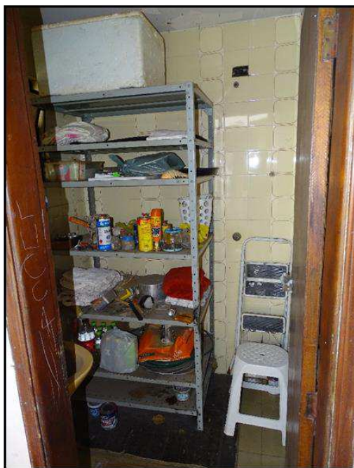
Vista do banheiro da edícula do imóvel avaliando.
