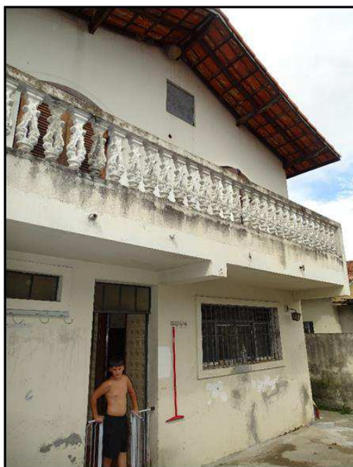
Vista detalhada da fachada dos fundos do imóvel avaliando.
