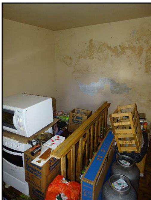
Vista do quarto da edícula do imóvel avaliando.
