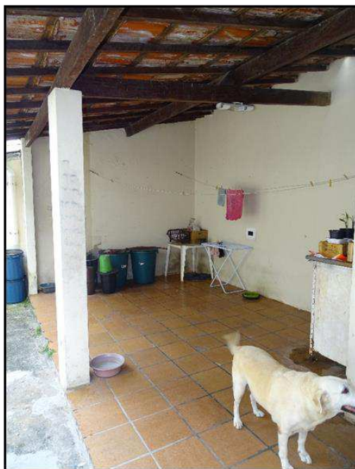
Vista do abrigo desmontável nos fundos do imóvel avaliando.
