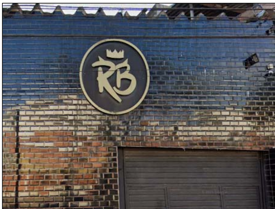
Foto 01. Fachada do imóvel avaliando.
