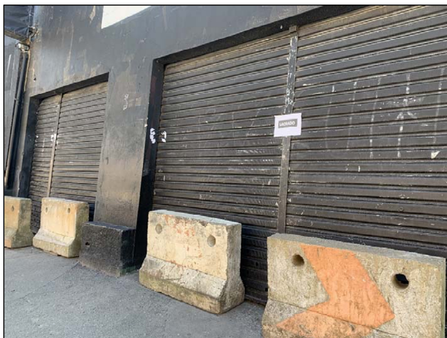
Foto 03. Detalhe da entrada do imóvel avaliando.
