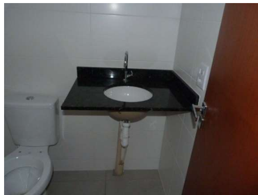
Fotos 33, 34, 35 e 36: destacando os detalhes do banheiro da suíte, vaso sanitário com caixa acoplada, bancada de granito com cuba e demais metais sanitários instalados, forro de placas de isopor texturizado com perfis metálicos, pisos e paredes revestidos com material cerâmico, esquadria metálica pré-montada, com pintura.
