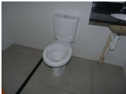
Fotos 33, 34, 35 e 36: destacando os detalhes do banheiro da suíte, vaso sanitário com caixa acoplada, bancada de granito com cuba e demais metais sanitários instalados, forro de placas de isopor texturizado com perfis metálicos, pisos e paredes revestidos com material cerâmico, esquadria metálica pré-montada, com pintura.
