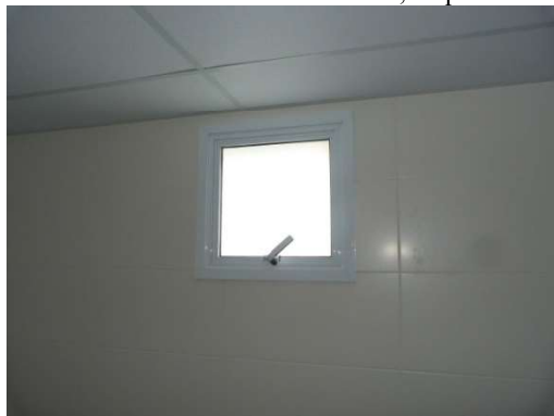
Fotos 33, 34, 35 e 36: destacando os detalhes do banheiro da suíte, vaso sanitário com caixa acoplada, bancada de granito com cuba e demais metais sanitários instalados, forro de placas de isopor texturizado com perfis metálicos, pisos e paredes revestidos com material cerâmico, esquadria metálica pré-montada, com pintura.
