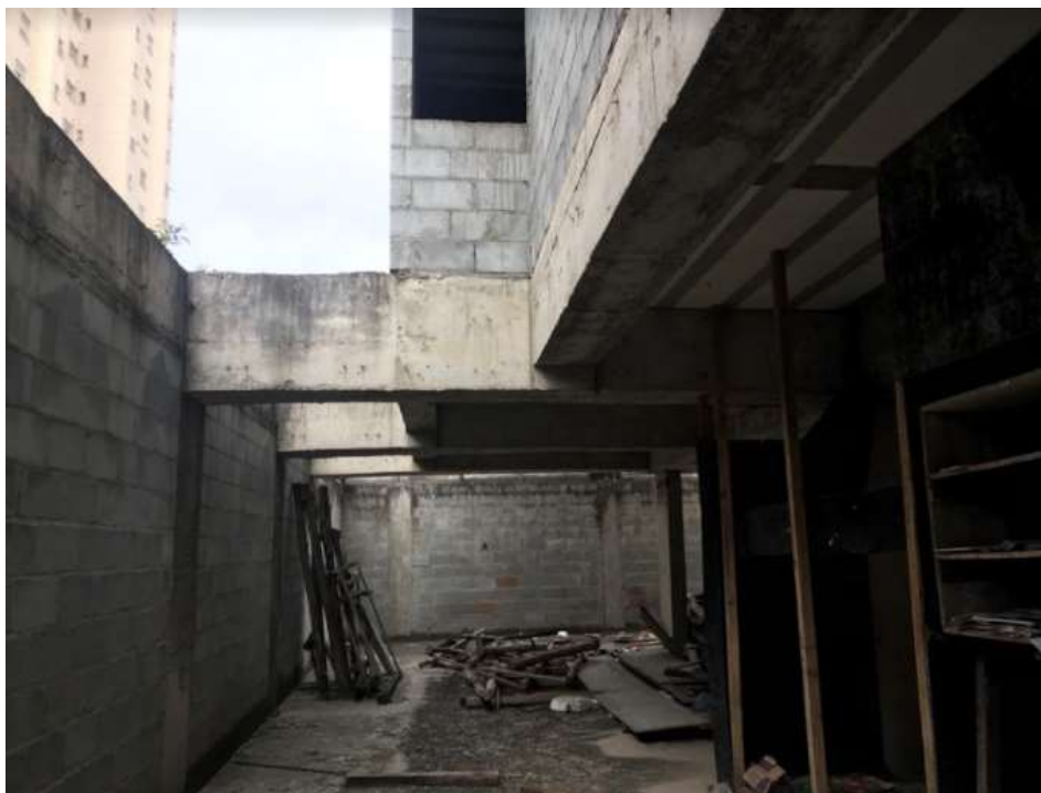
Fotos internas do imóvel da vistoria – rua vitória régia, 169
