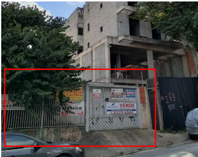
Vizinho lateral esquerdo (fachada) – imóvel residência unifamiliar
