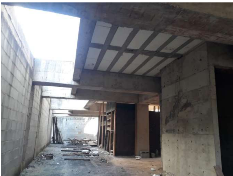
Fotos internas do imóvel da vistoria – rua vitória régia, 169
