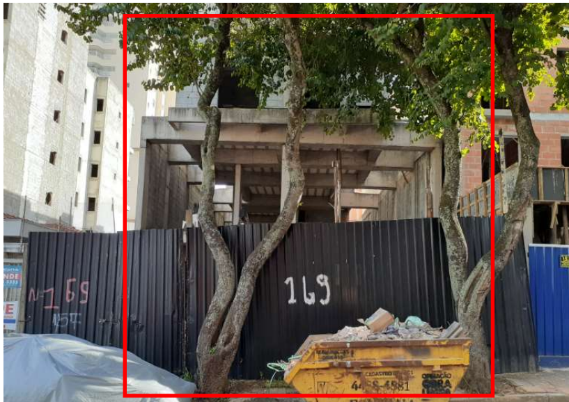
Frente do imóvel (fachada) – Rua Vitória Régia, 169
