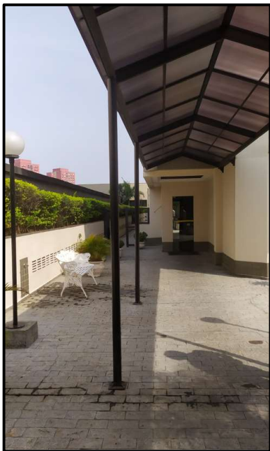
Foto 4: Pavimento Térreo – Acesso ao hall de elevadores
