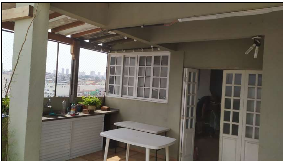
Foto 18: Apartamento 134 –Área externa do andar superior
