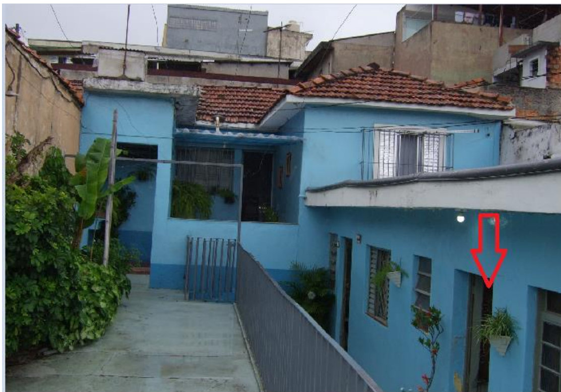
VISTA DO ACESSO A CASA 1
