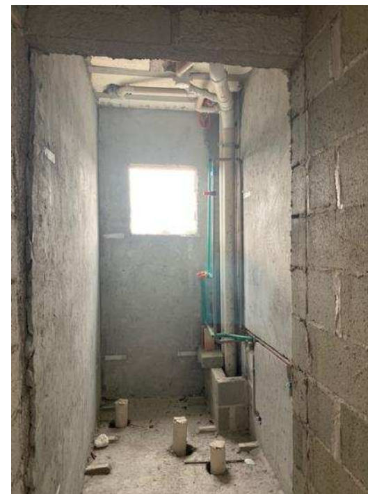
Foto 09. Vista de outro banheiro de um dos apartamentos da Torre 1. Vide aí as tubulações da rede hidrossanitária do shaft. Observe aí também, que faltam revestimento e instalação de esquadrias.
