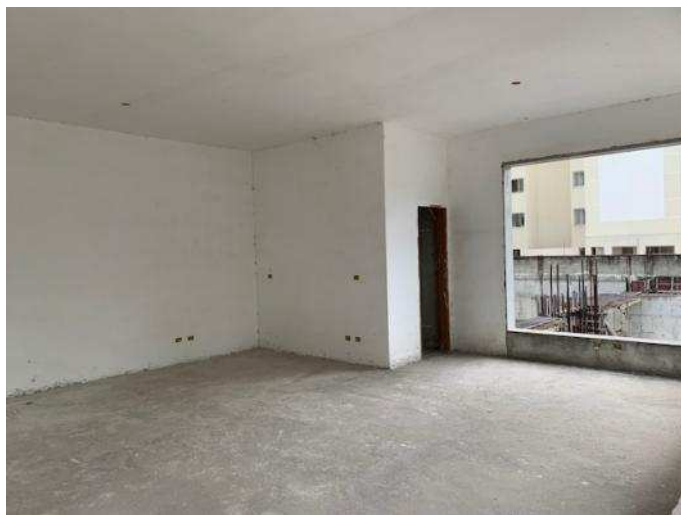
Foto 16. Vista de umas salas comerciais do pavimento térreo do bloco comercial. Observa-se aí, que possui revestimento nas paredes, contrapiso executado e instalação elétrica feita. Em vistoria verificou-se que foram realizadas instalações hidrossanitárias, ficando restante a instalação das esquadrias de vidro da fachada.
