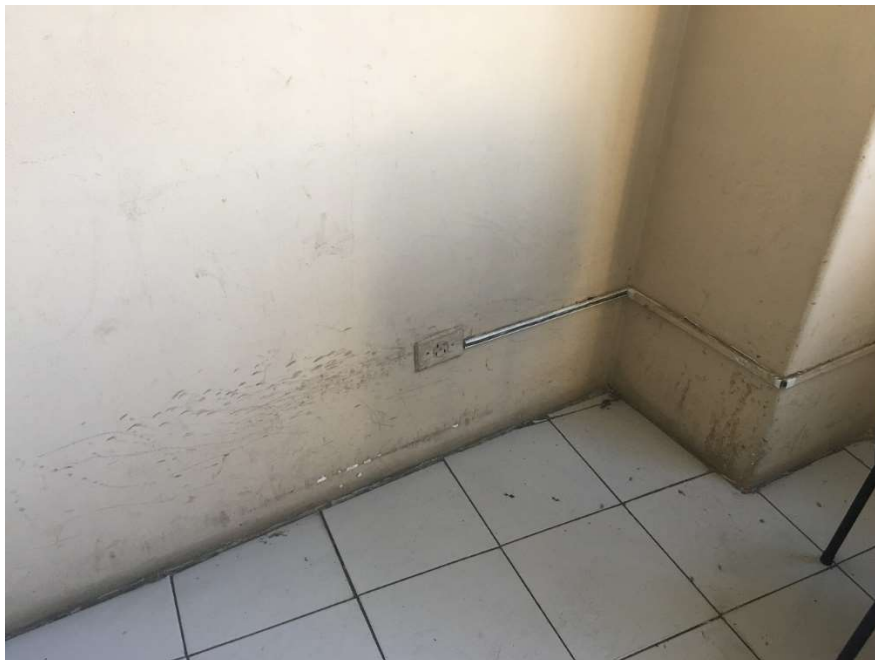
ASPECTOS GERAIS - SALA 31
