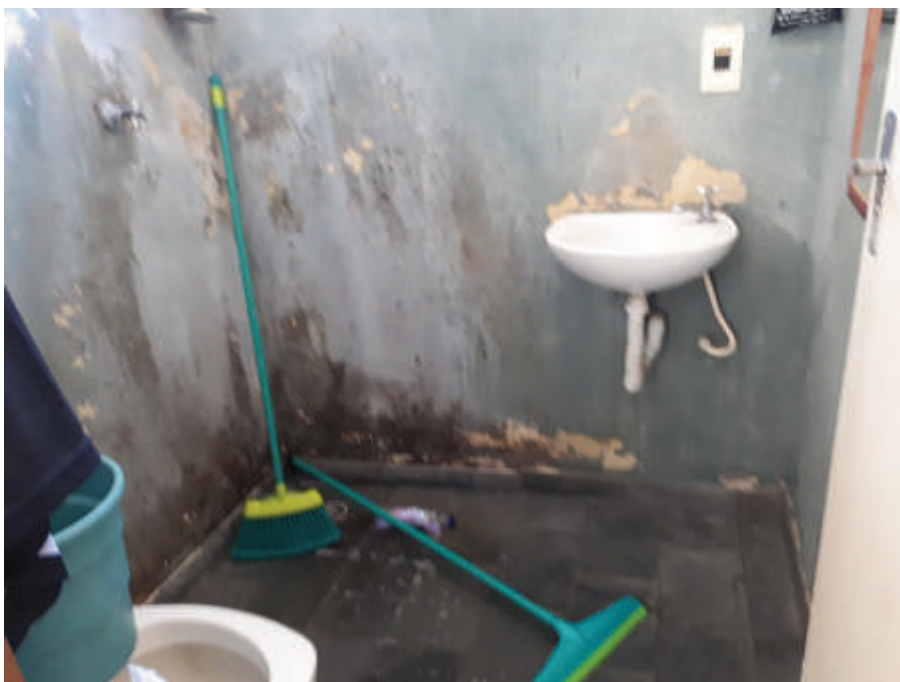
Vista do banheiro do imóvel avaliando
