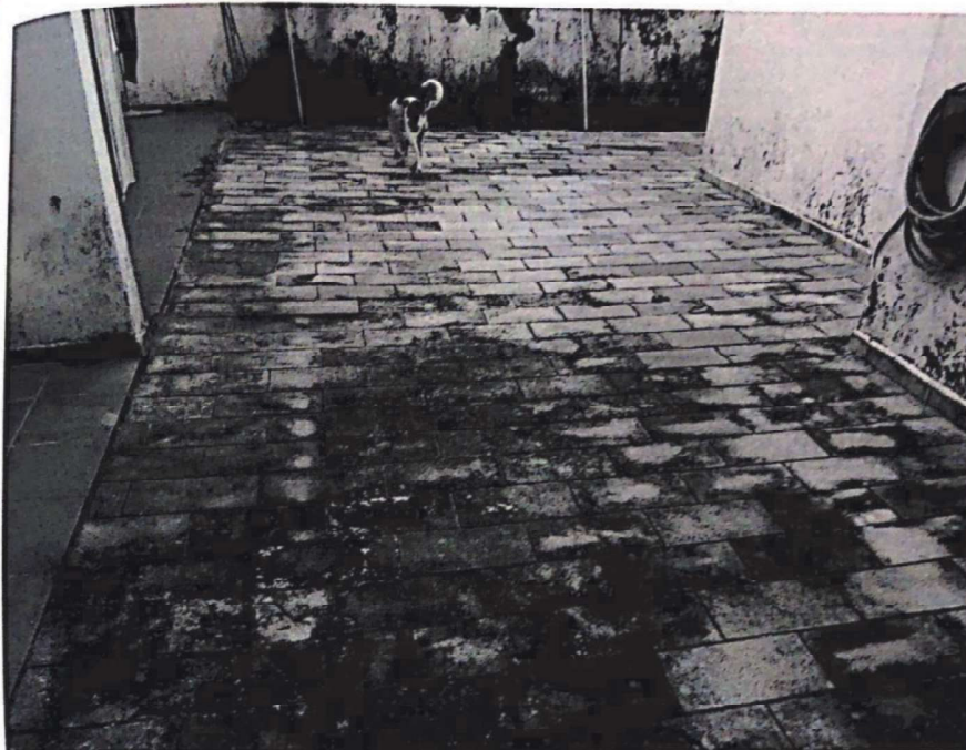
FOTO 40 – Detalhe piso externo.
