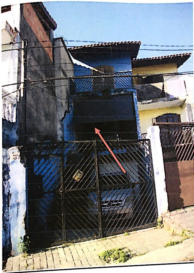
Foto 5 : Aspectos da fachada da edificação nº 37 da Rua Sebastião Marques, construída no terreno objeto da penhora.
