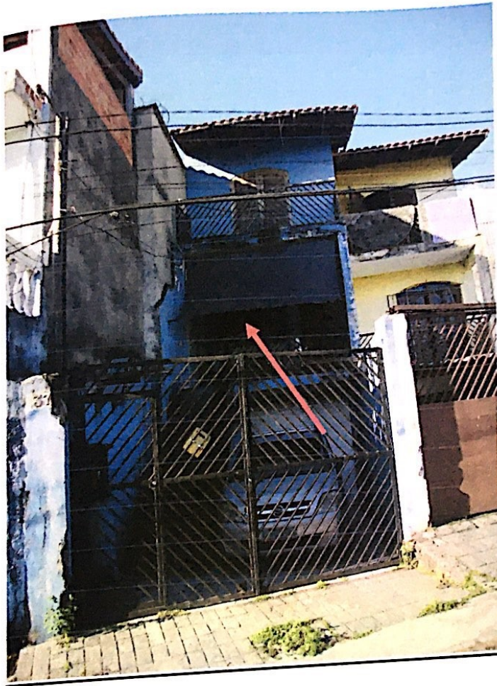
Foto 7 : Aspectos da fachada da edificação nº 37 da Rua Sebastião Marques, construída no terreno objeto da penhora.
