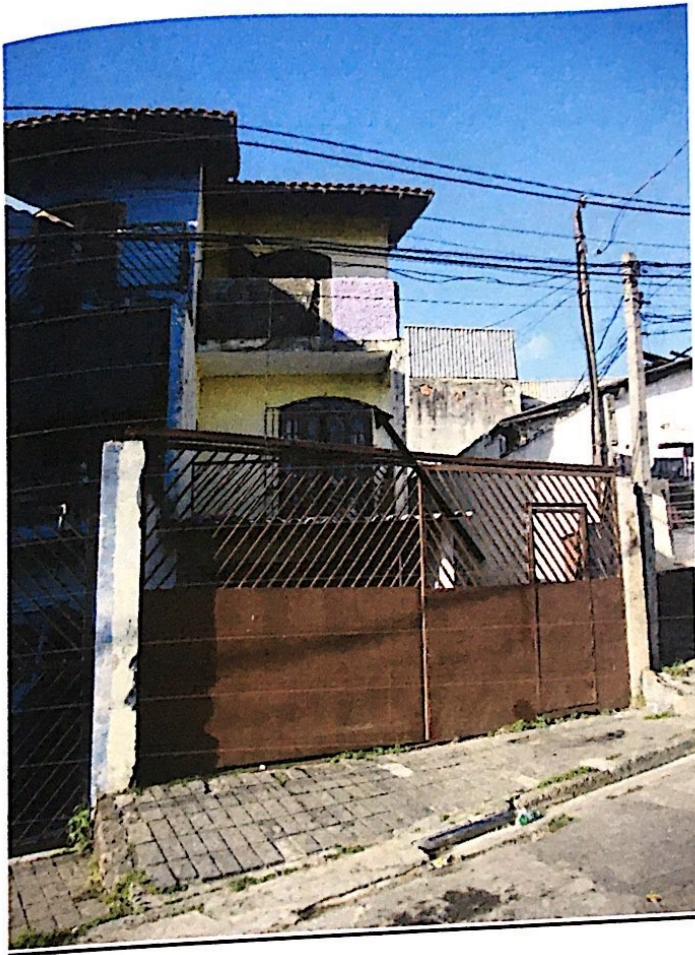
Foto 6 : Aspectos da fachada da edificação nº 31 da Rua Sebastião Marques, construída no terreno objeto da penhora.
