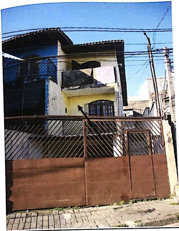
Foto 8 : Aspectos da fachada da edificação nº 31 da Rua Sebastião Marques, construída no terreno objeto da penhora.
