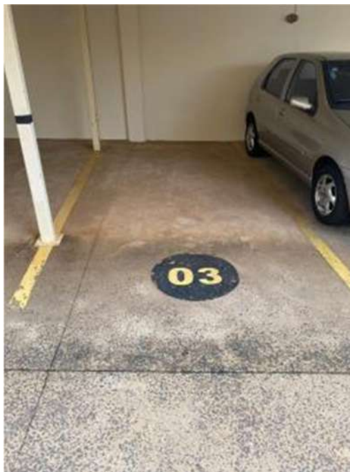
VISTA DA GARAGEM DO IMÓVEL.
