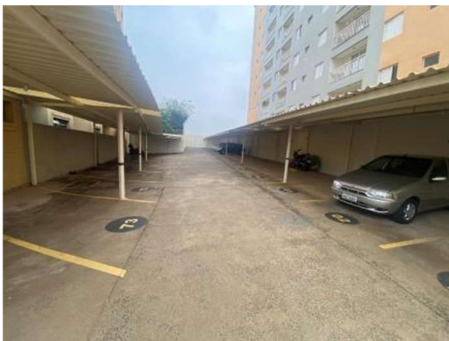
VISTA DO ESTACIONAMENTO DO CONDOMÍNIO.
