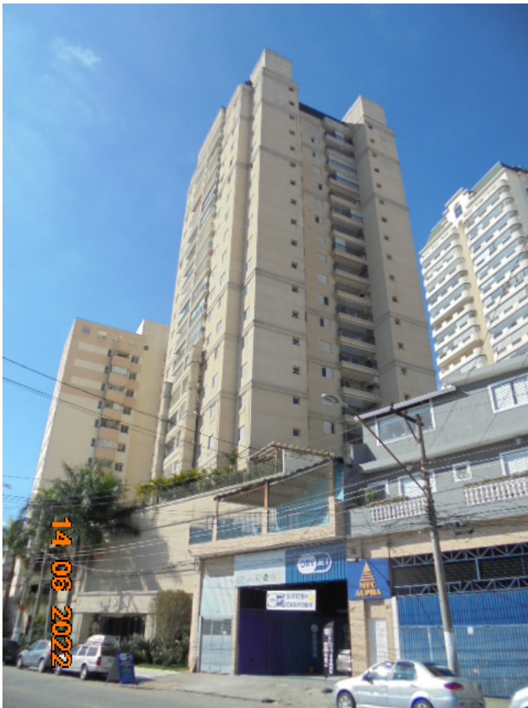
FOTO Nr.04: Panorama da fachada lateral direita do Edifício Mont Blanc.
