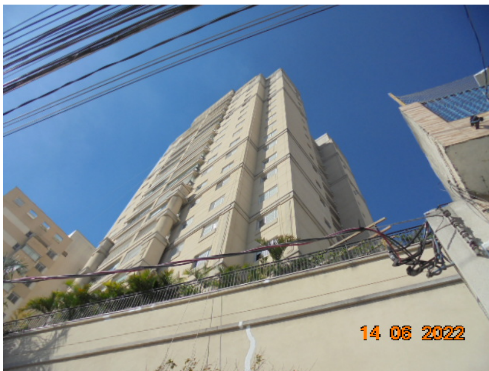
FOTO Nr.07: Vista da frente do pavimento térreo e fachada frontal do Ed. Mont Blanc.
