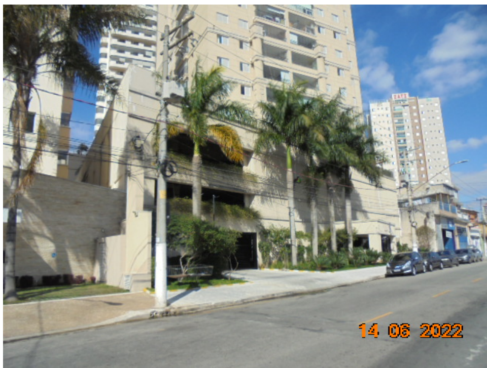
FOTO Nr.05: Vista do acesso à portaria e às garagens do Condomínio, onde se situa a unidade avalianda.
