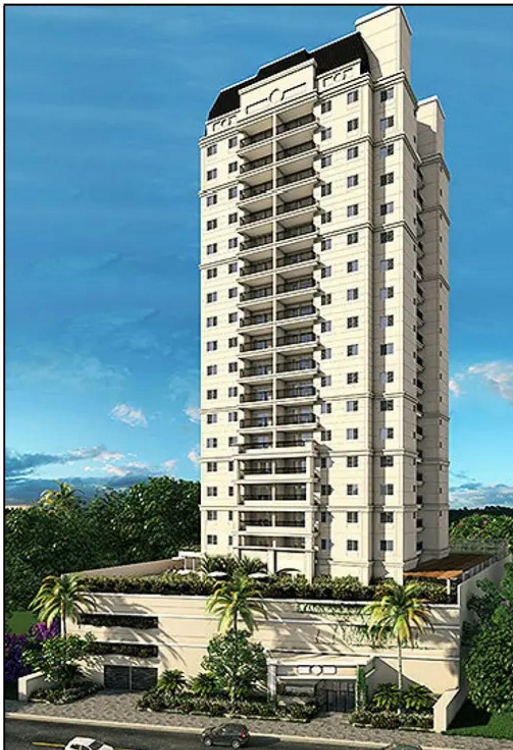
FIGURA Nr.06: Fachada de referência ilustrada no site da Construtora do Edifício.
