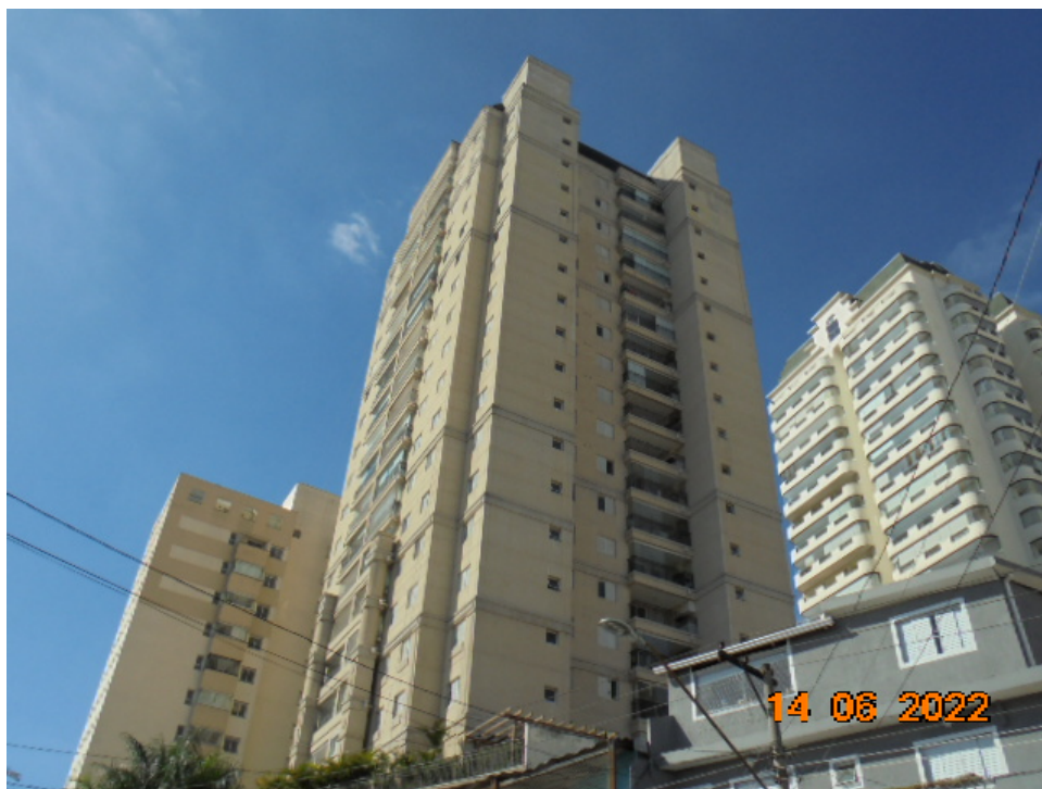
FOTO Nr.08: Detalhe da fachada lateral direita do Edifício Mont Blanc.
