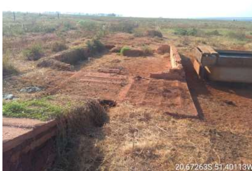
Foto 23 – Parte da Selaria demolida
