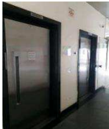
Hall de elevadores
