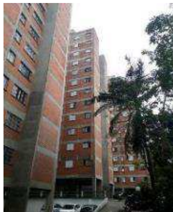
Vistas do Arruamento interno
