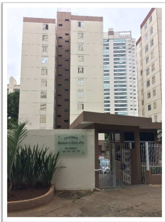
FOTO 01 – Entrada do Condomínio Santa Cruz
