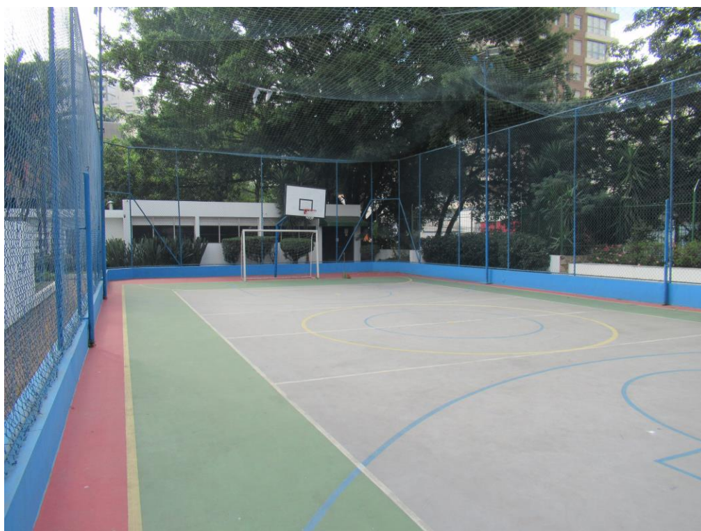
Foto nº. 5 – Vista da quadra poliesportiva.
