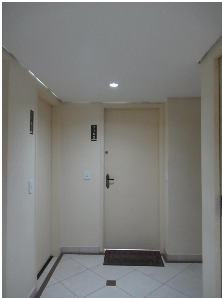
Foto nº. 28 – Vista da porta de entrada.
