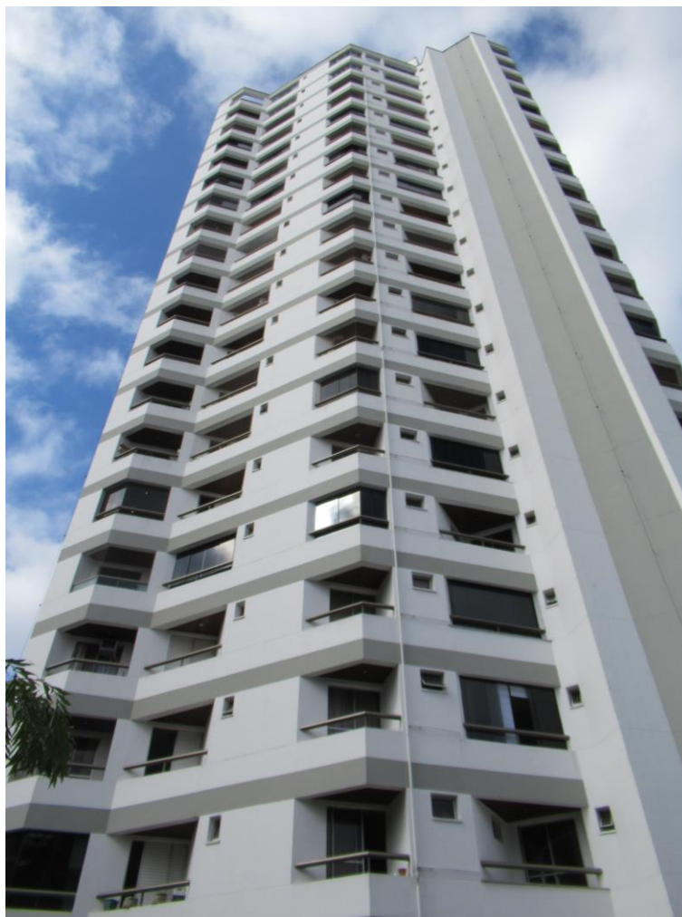
Foto nº. 4 – Vista da fachada do Bloco A, onde se localizam os imóveis avaliados no presente laudo.
