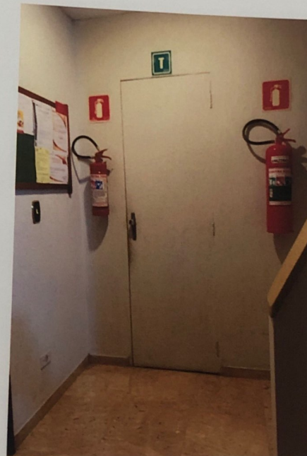
Foto 28 Hall elevador e escada térreo
