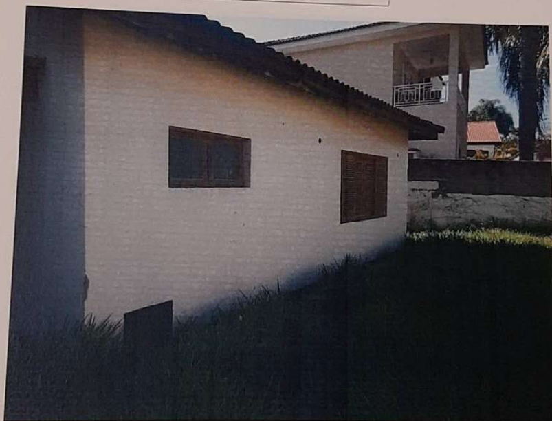
OUTRA VISTA DA FACHADA DOS FUNDOS.
