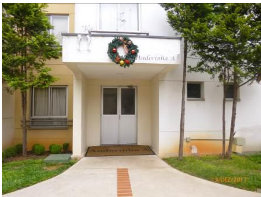
Foto nº. 11 – Vista da entrada da Torre A – Edifício Andorinha, onde se situa o apartamento avaliado no presente laudo.
