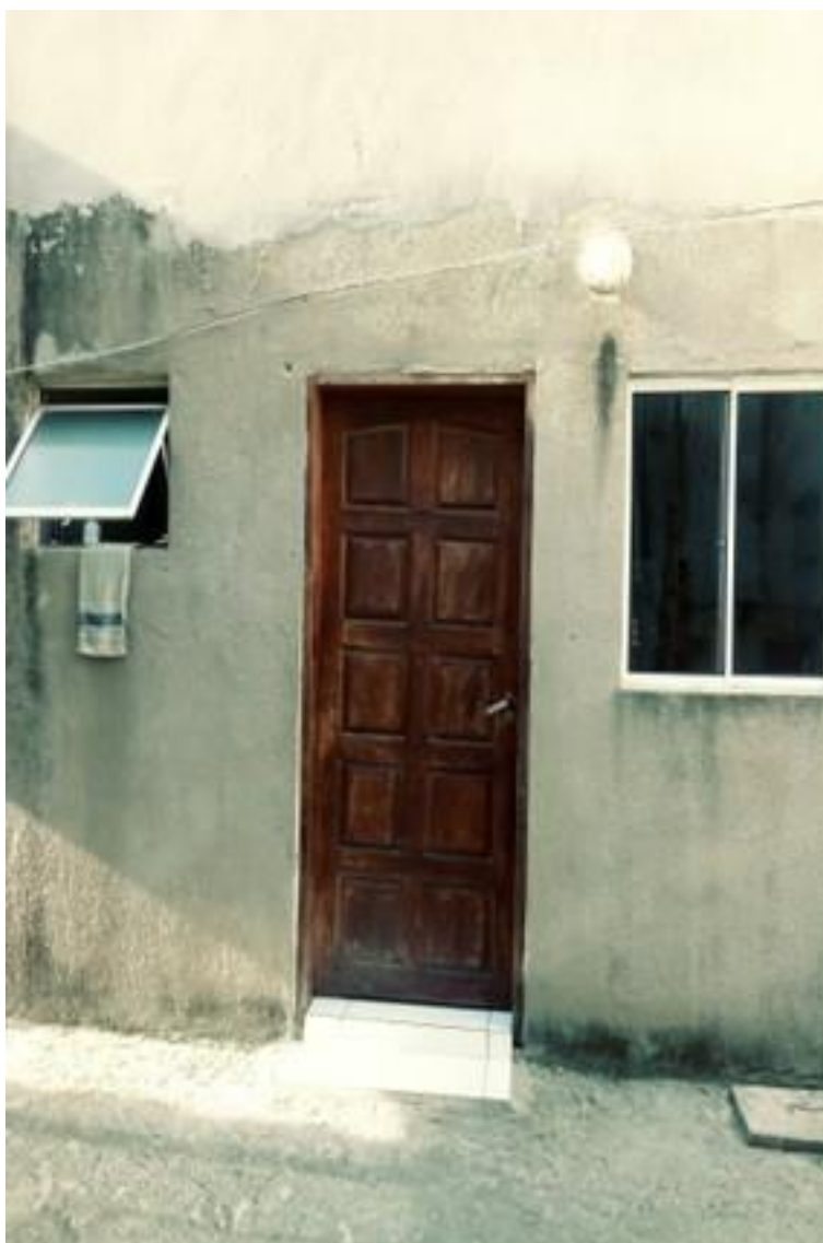
Foto nº 11: Vista da porta de acesso à copa-cozinha da construção principal, através da lateral do terreno.
