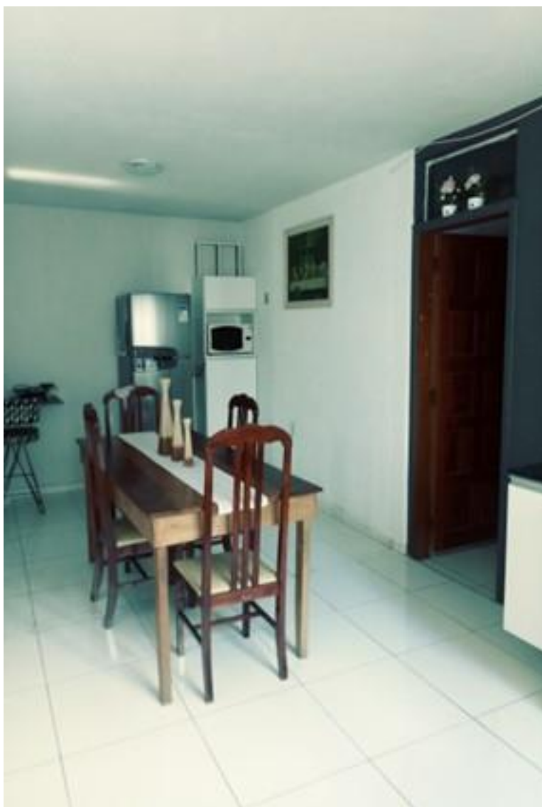
Foto nº 12: Vista da copa cozinha, com piso revestido em porcelanato, esquadrias de alumínio, pintura em látex e forro em laje.
