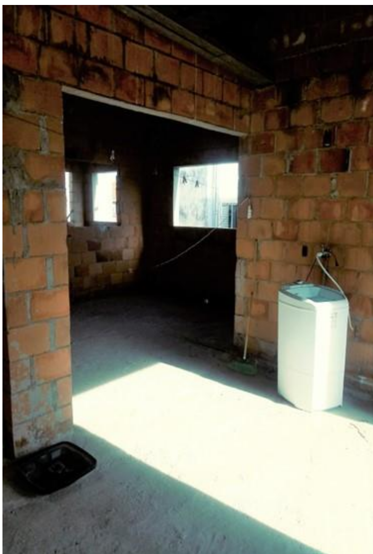
Foto nº 09: Outra vista da laje superior.
