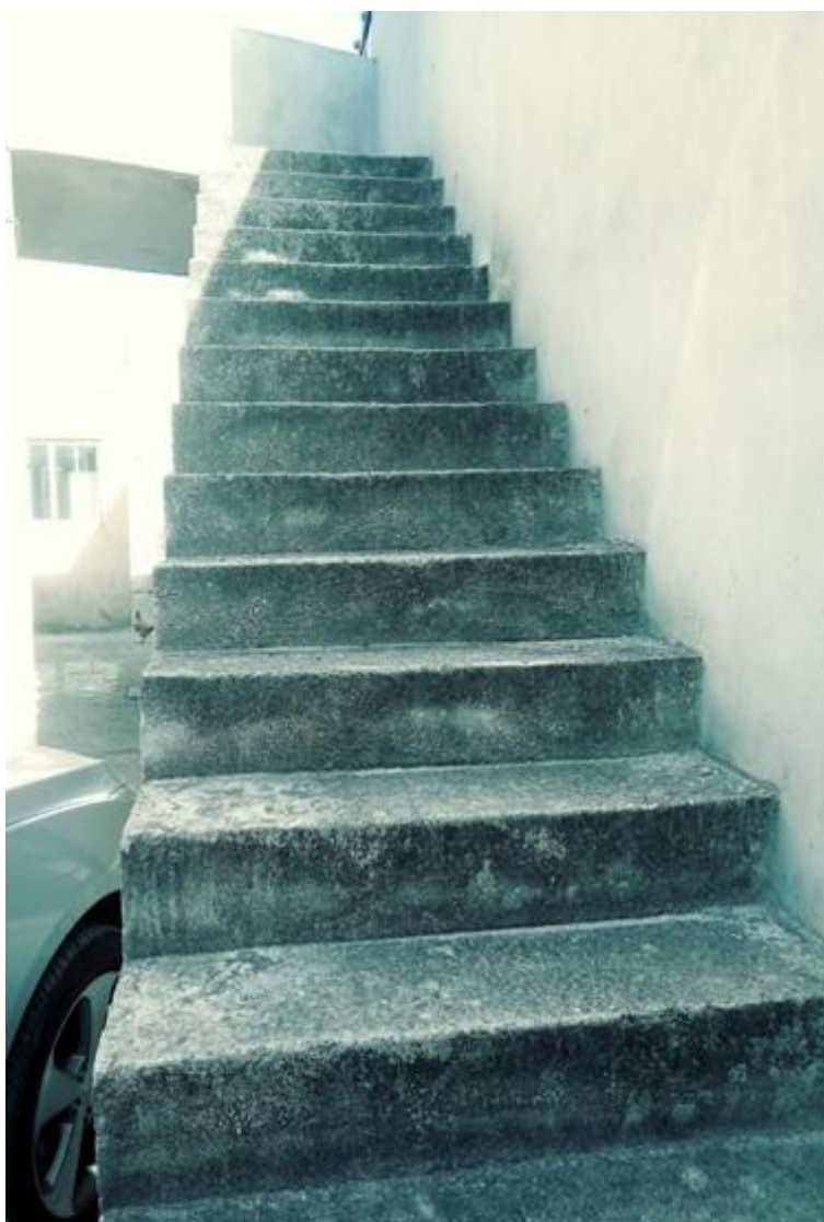
Foto nº 06: Detalhe da escada externa, sem acabamentos.
