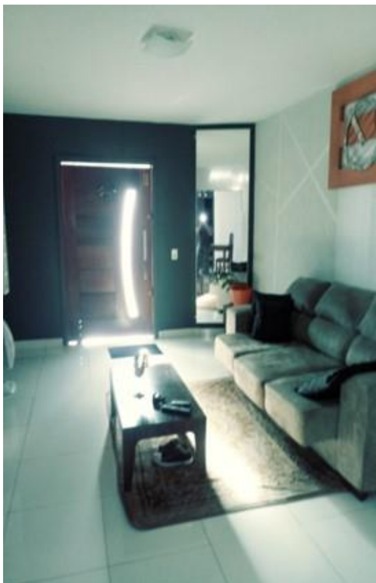
Foto nº 13: Vista da sala, com porta de madeira, janela em alumínio de correr, laje, pintura em látex e piso em porcelanato.
