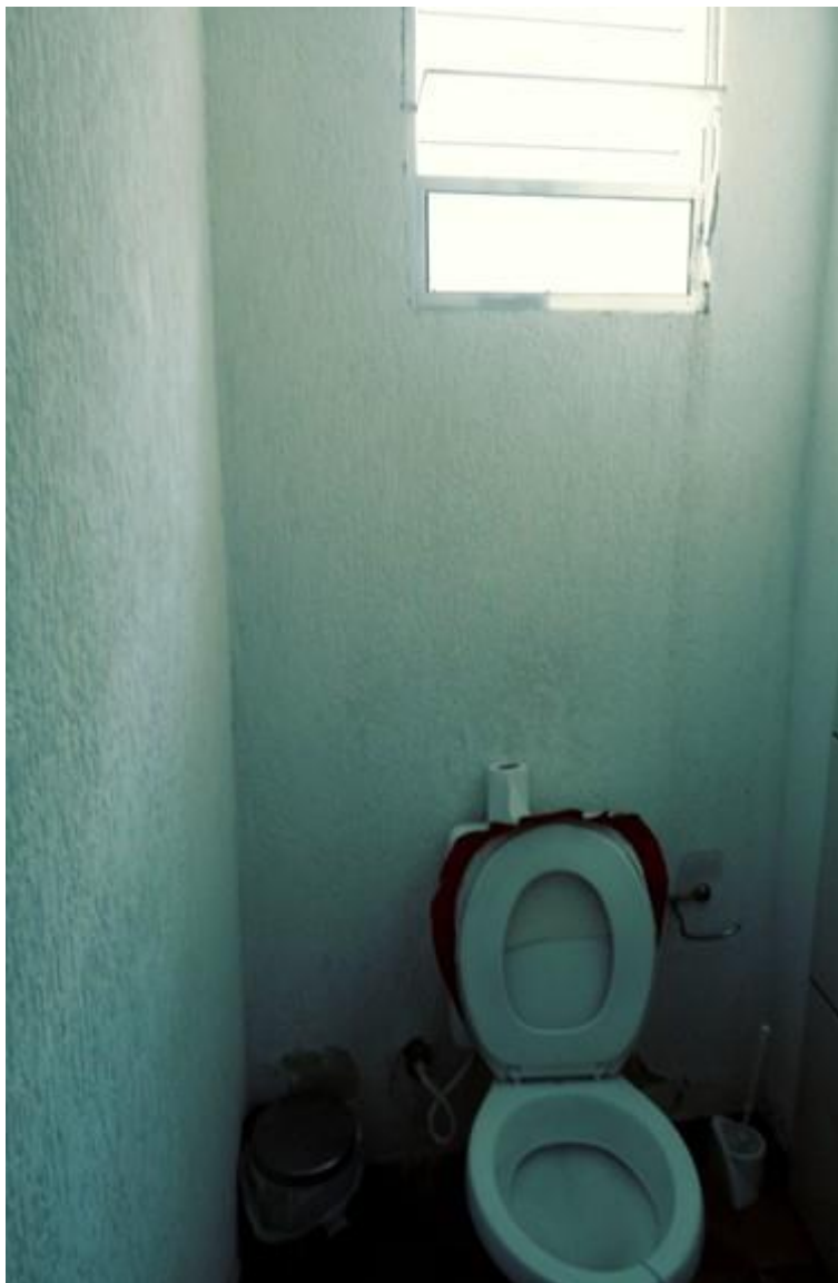
Foto nº 24: Vista do WC, ao lado da cozinha. Paredes com pintura à base de látex, piso cerâmico e janela basculante de alumínio.
