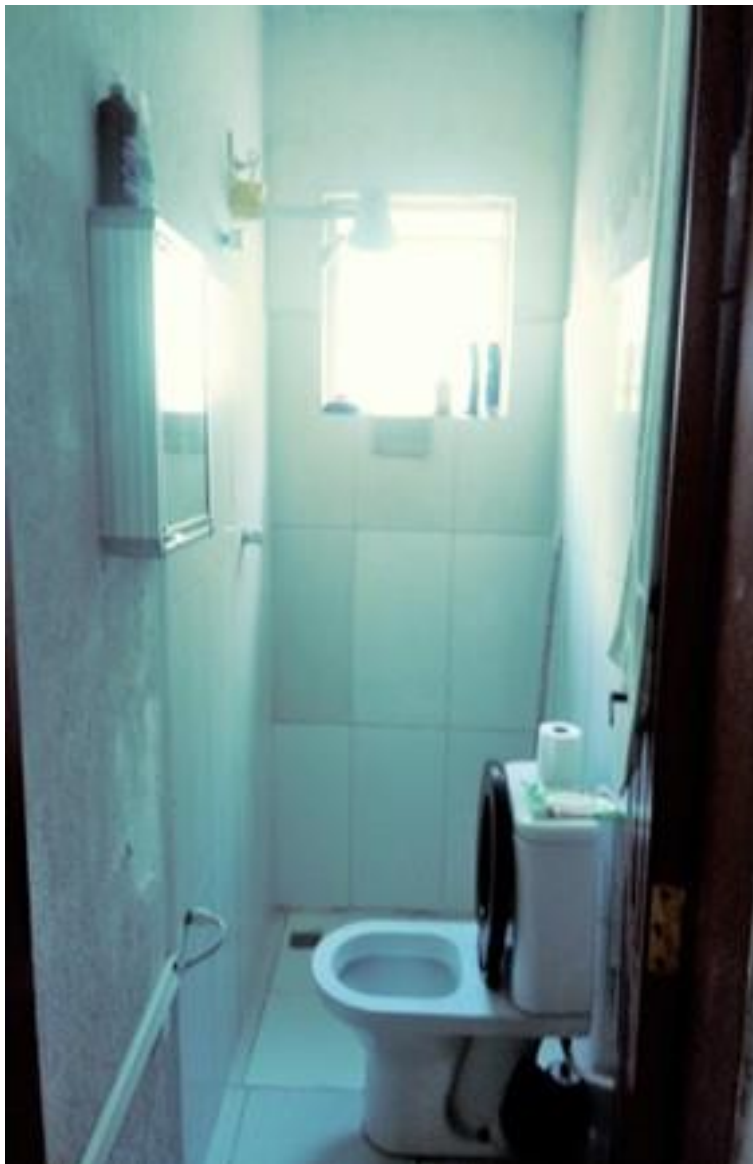
Foto nº 19: Banheiro da suíte. Totalmente azulejado, com esquadria maxim-ar de alumínio e forro em laje.
