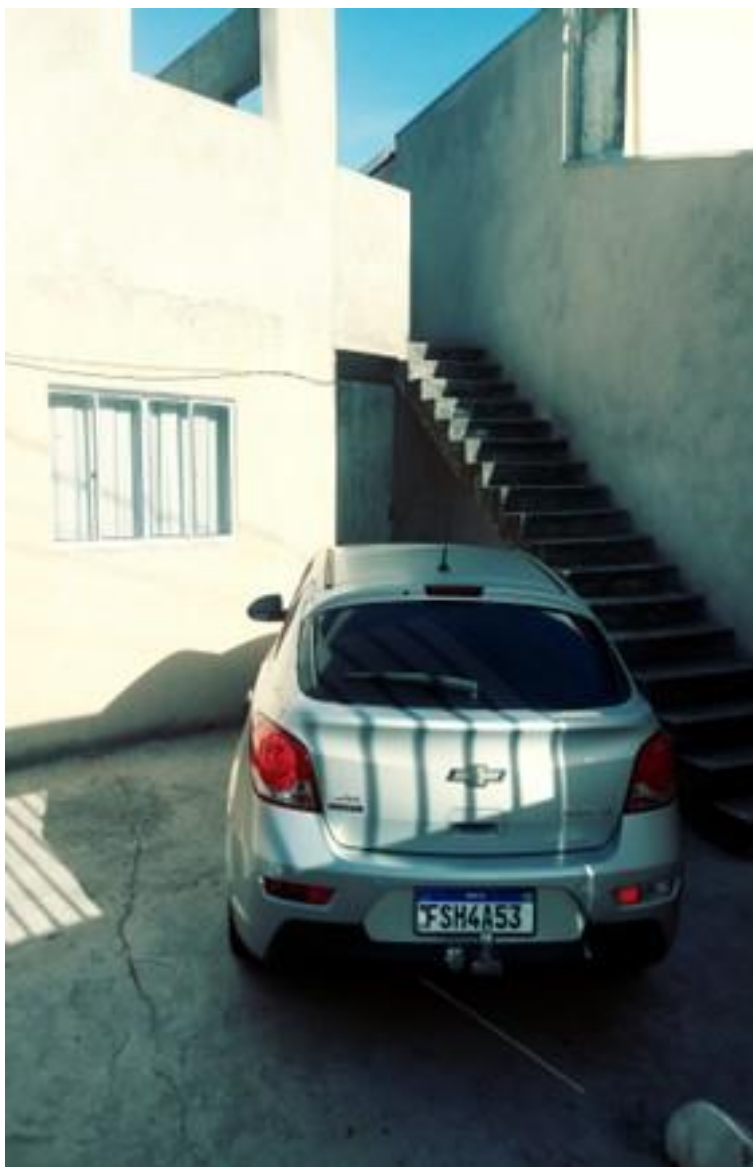
Foto nº 05: Outra vista da frente, com garagem em piso cimentado e à direita, a escada de acesso ao pavimento superior.
