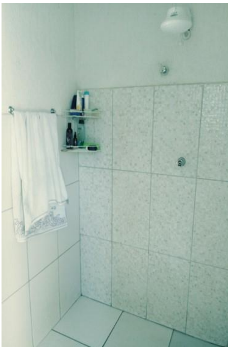
Foto nº 23: Banheiro da edícula, com paredes em azulejos em barra, piso cerâmico e forro em laje. Não possui janela.
