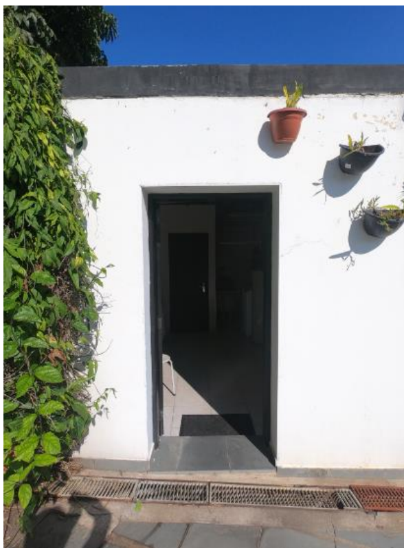
Figura 15. Área de serviço
