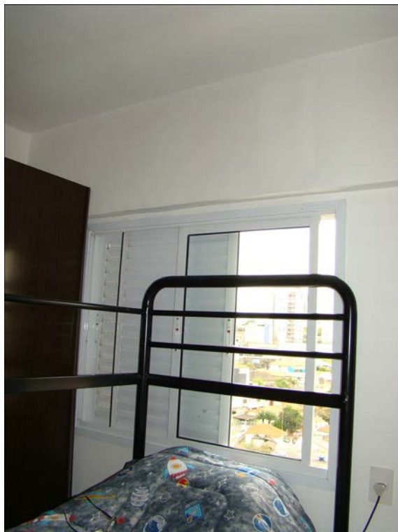
A foto ilustra o Dormitório 03 do apartamento nº 101, no 10º andar do Edifício Morada Bela Vista (Condomínio Atmosphaera).
