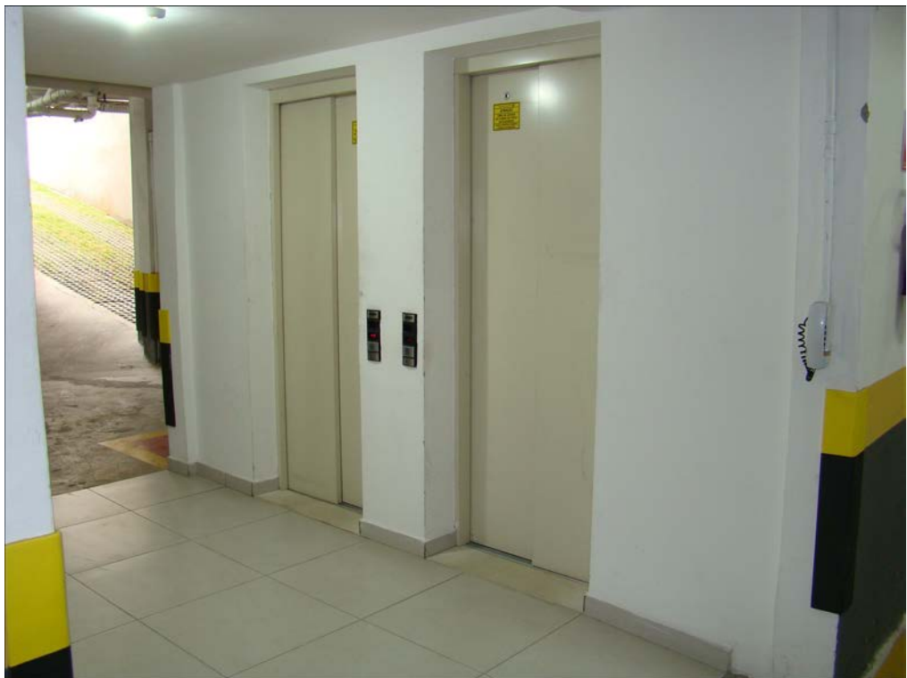
A foto ilustra os Elevadores no Subsolo do Edifício Morada Bela Vista (Condomínio Atmospha).
