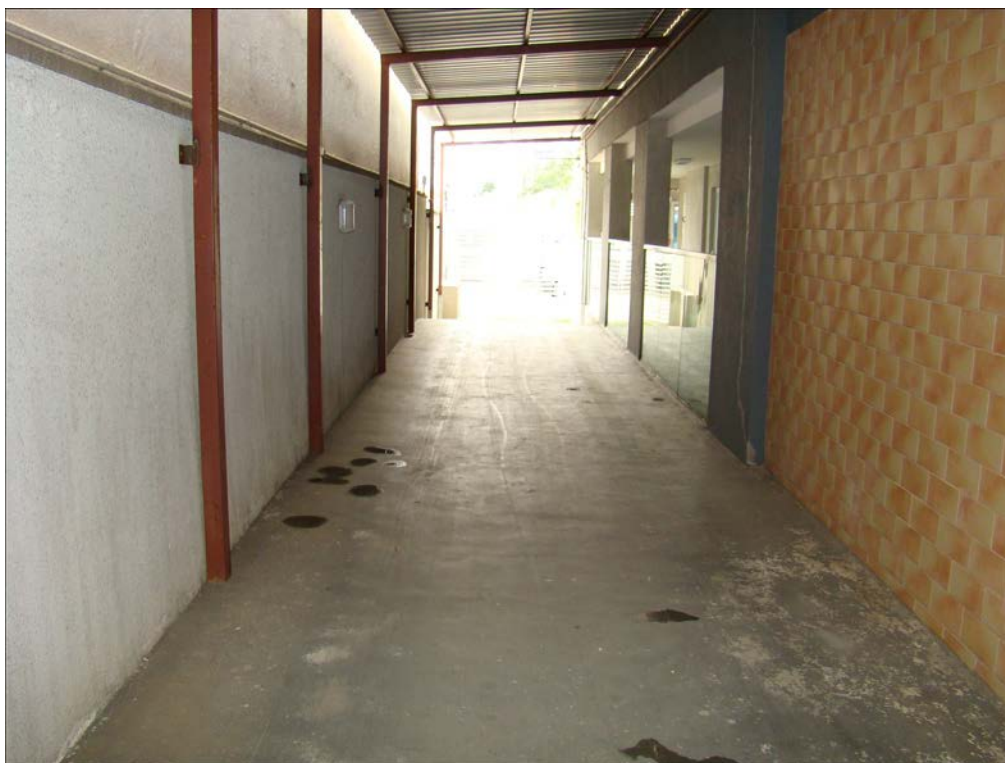
A foto ilustra a Circulação dos automóveis no andar térreo do Edifício Morada Bela Vista (Condomínio Atmosphaera).
