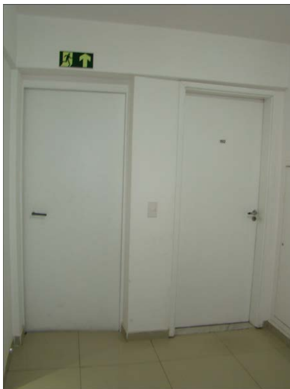
A foto ilustra o acesso para a Escada no Hall do 10º andar do Edifício Morada Bela Vista (Condomínio Atmosphaera).
