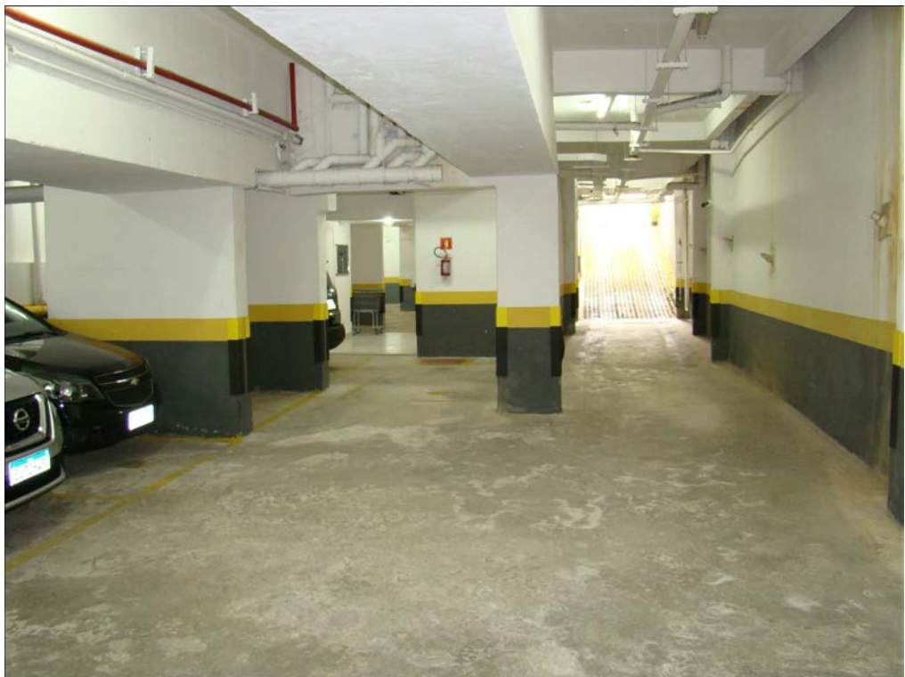
A foto ilustra o Subsolo do Edifício Morada Bela Vista (Condomínio Atmospha).
