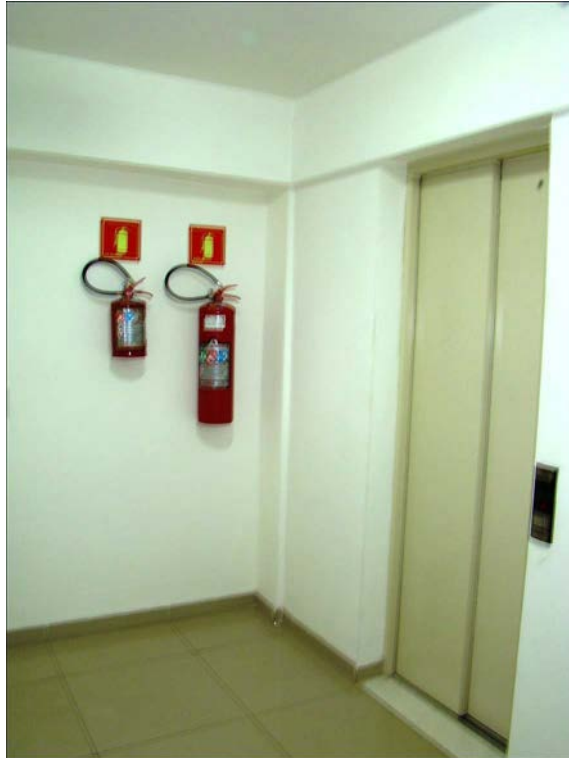
A foto ilustra o Elevador no Hall do 10º andar do Edifício Morada Bela Vista (Condomínio Atmospha).
