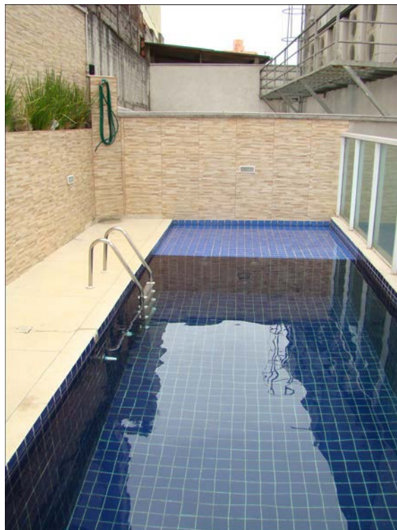
A foto ilustra a Piscina no fundo do Edifício Morada Bela Vista (Condomínio Atmospha).
