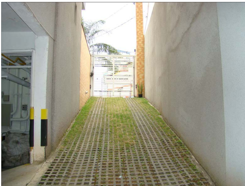
A foto ilustra a Rampa de acesso ao logradouro, observada do Subsolo, no Edifício Morada Bela Vista (Condomínio Atmospha).
