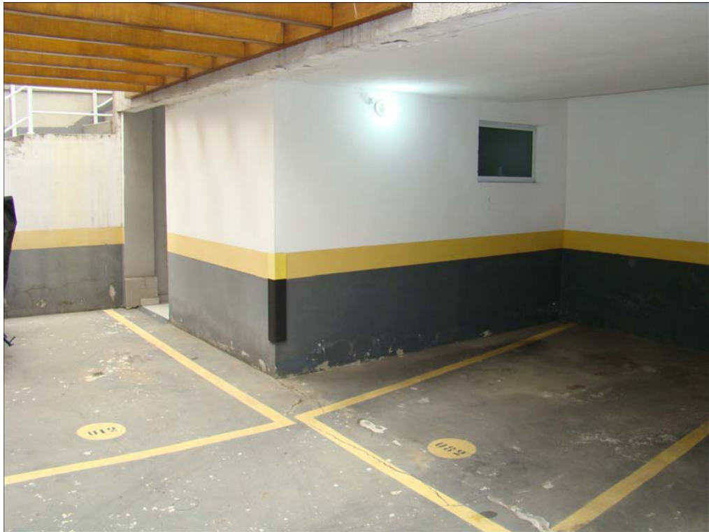
A foto ilustra o Centro de Medição no andar térreo do Edifício Morada Bela Vista (Condomínio Atmosphaera).
