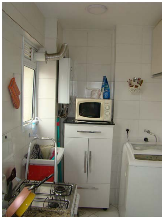
A foto ilustra parte da Cozinha e a Lavanderia do apartamento nº 101, no 10º andar do Edifício Morada Bela Vista (Condomínio Atmosphaera).
