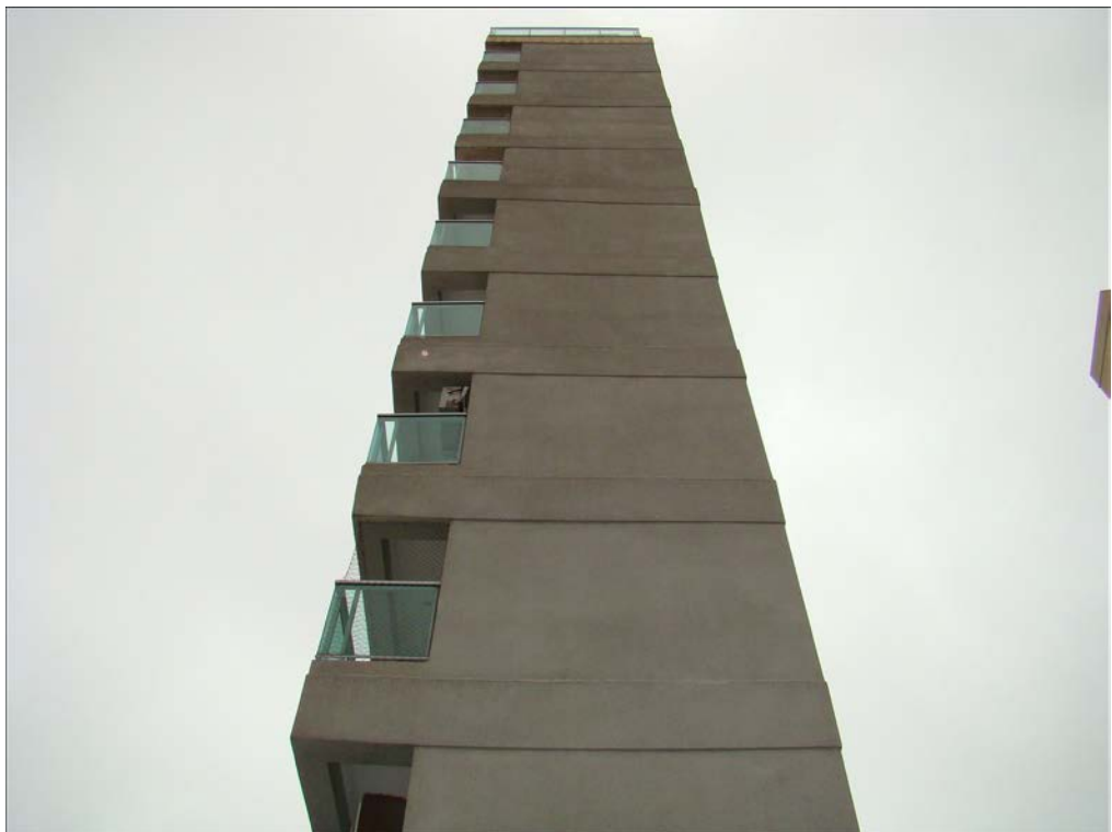
A foto ilustra a fachada de fundo do Edifício Morada Bela Vista (Condomínio Atmospha).
