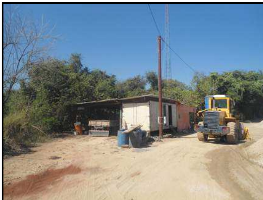
GALPÃO DE SERVIÇOS DO PORTO DE AREIA
