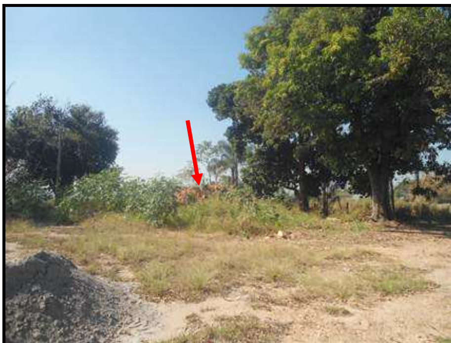
VESTÍGIOS DE DEMOLIÇÃO DE CONSTRUÇÃO
