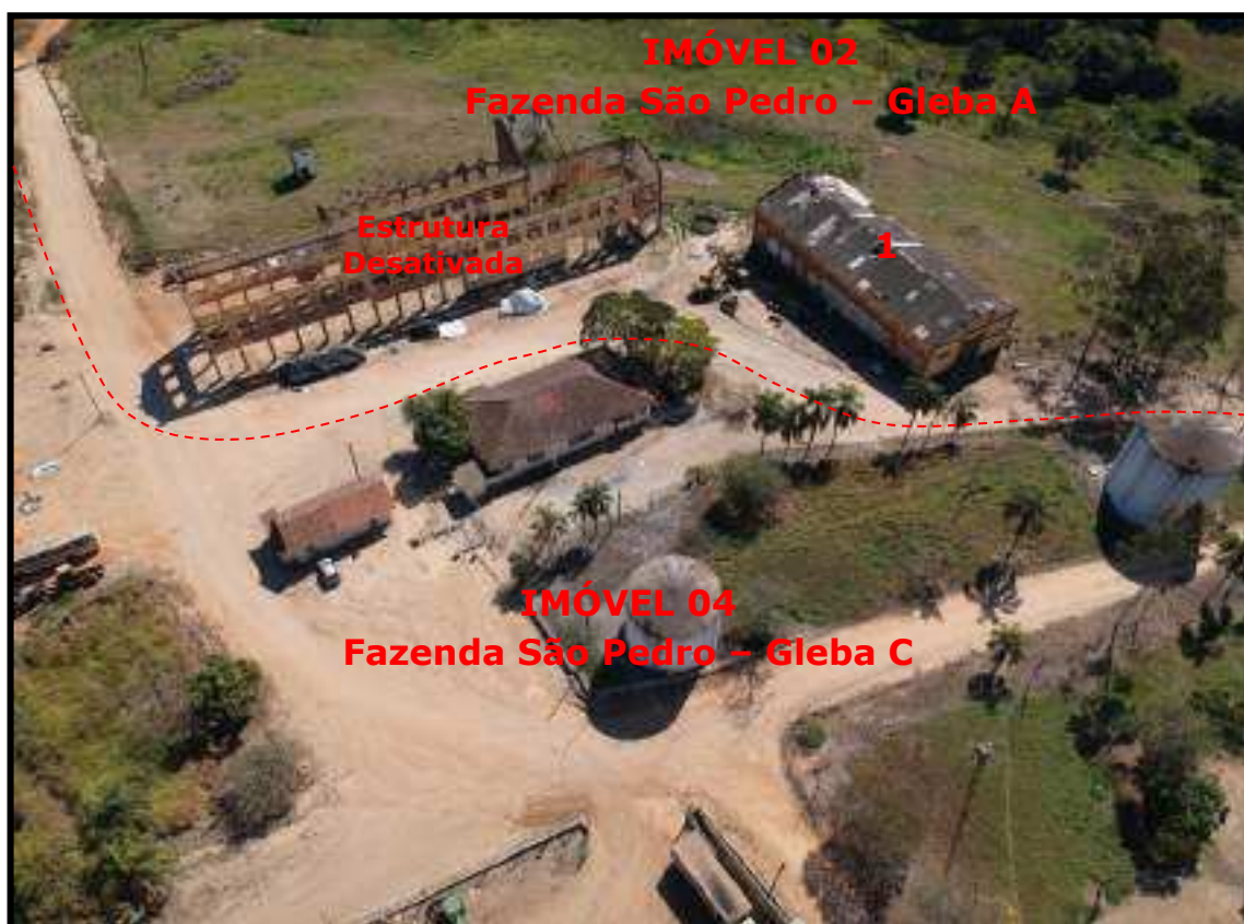
VISTA GERAL DA 1ª CONCENTRAÇÃO DAS BENFEITORIAS DO IMÓVEL 02 LOCALIZAÇÃO DA BENFEITORIA 1
