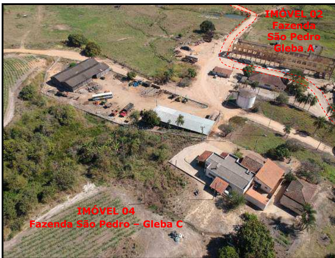
VISTA GERAL DA 1ª CONCENTRAÇÃO DAS BENFEITORIAS DO IMÓVEL 04
