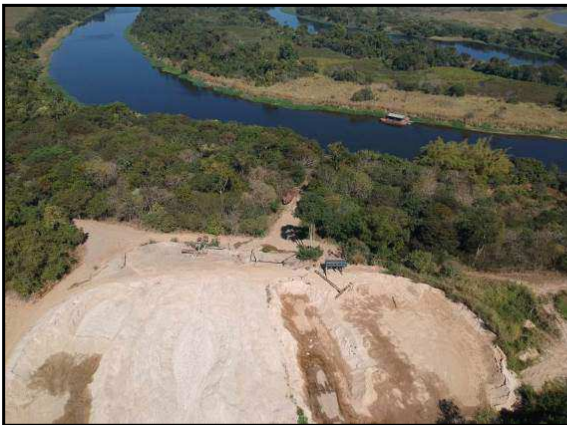
VISTA AÉREA DO PORTO DE AREIA
