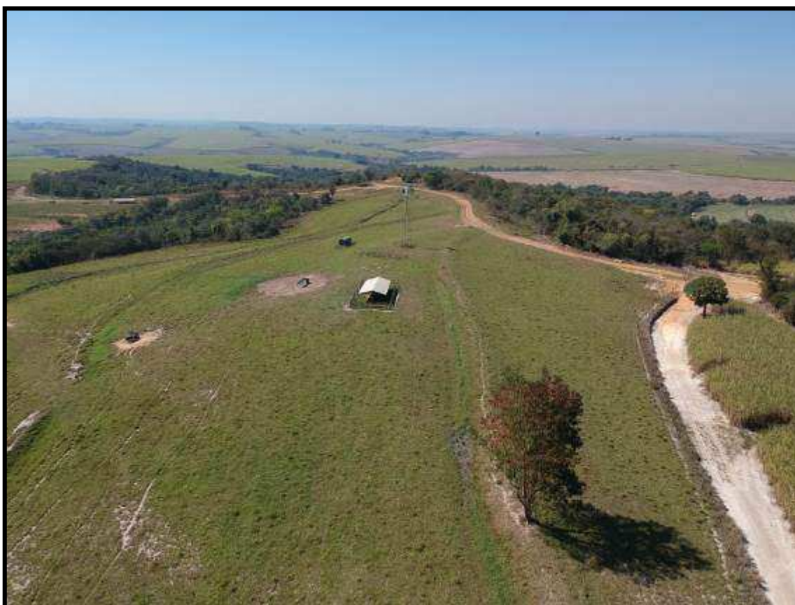
CONCENTRAÇÃO DAS BENFEITORIAS DO IMÓVEL 06
