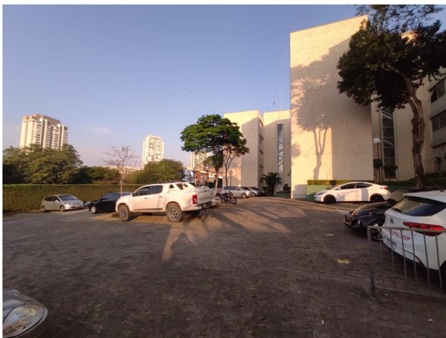
Figura 8 – Estacionamento – Fonte: Autor
