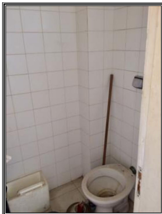
Banheiro de funcionário
