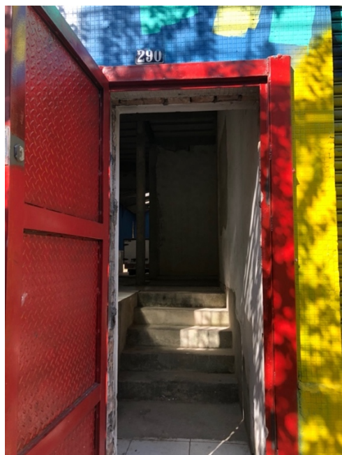
FOTO 9 - Vista parcial FACHADA externa – portão entrada aberto, escadaria piso de cimento
