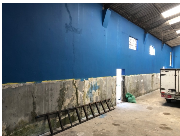
FOTO 19 - Vista parcial GALPÃO parede azul com porta para Área Lateral à esquerda
