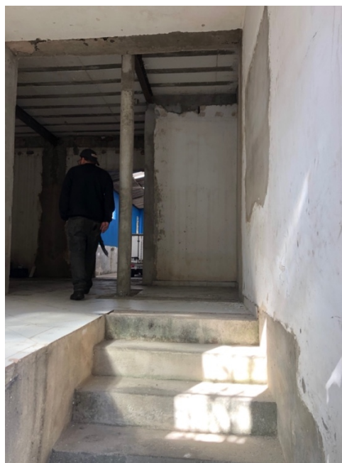
FOTO 10 - Vista interna – entrada, escadaria piso de cimento
