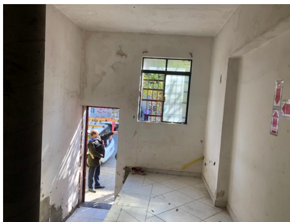
FOTO 14 - Vista do portão de entrada a partir do HALL DE ENTRADA
