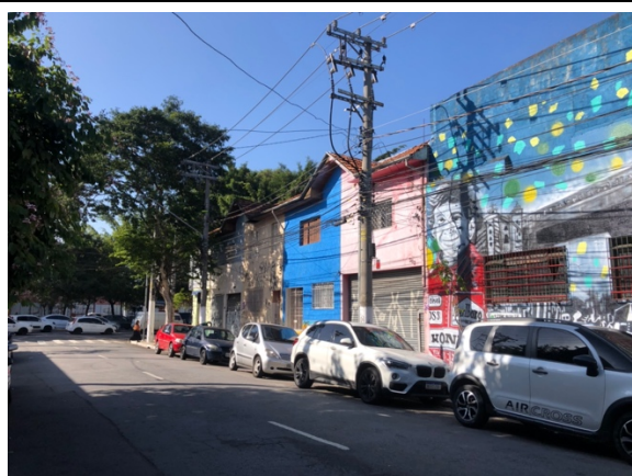
FOTO 2 - Vista parcial da FACHADA Imóvel Avaliando, ao fundo Av. Cruzeiro do Sul
