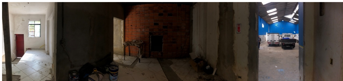
FOTO 46 - Vista panorâmica Portão de Entrada, HALL DE ENTRADA, GALPÃO parede azul
