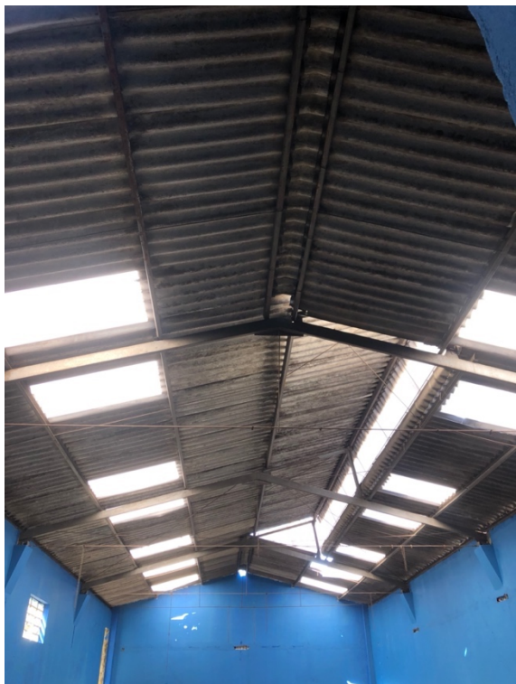
FOTO 23 - Vista teto do GALPÃO parede azul
