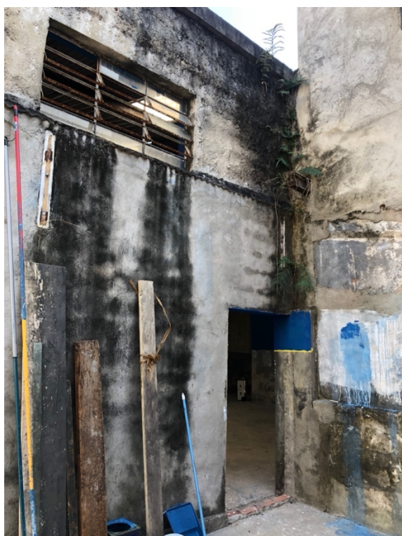
FOTO 31 - Vista parcial ÁREA LATERAL ao GALPÃO parede azul, porta para o GALPÃO parede azul,
