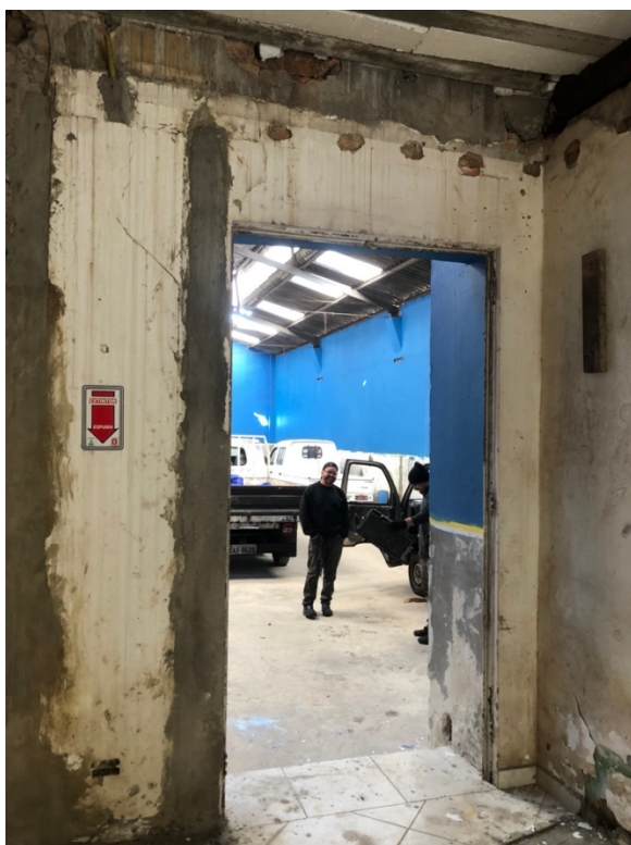
FOTO 17 - Vista parcial partir do HALL DE ENTRADA, GALPÃO parede azul
