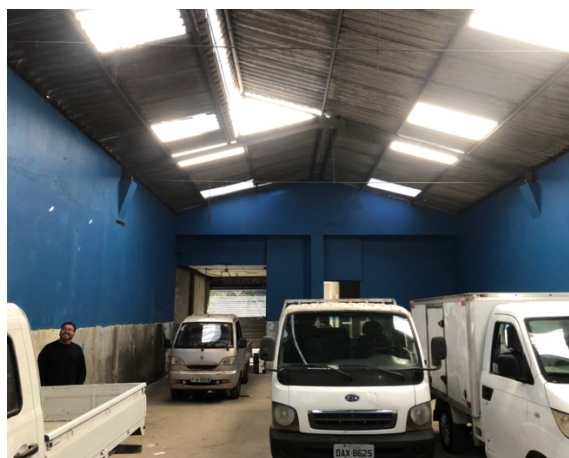
FOTO 20 - Vista GALPÃO parede azul do fundo em direção para frente do Imóvel
