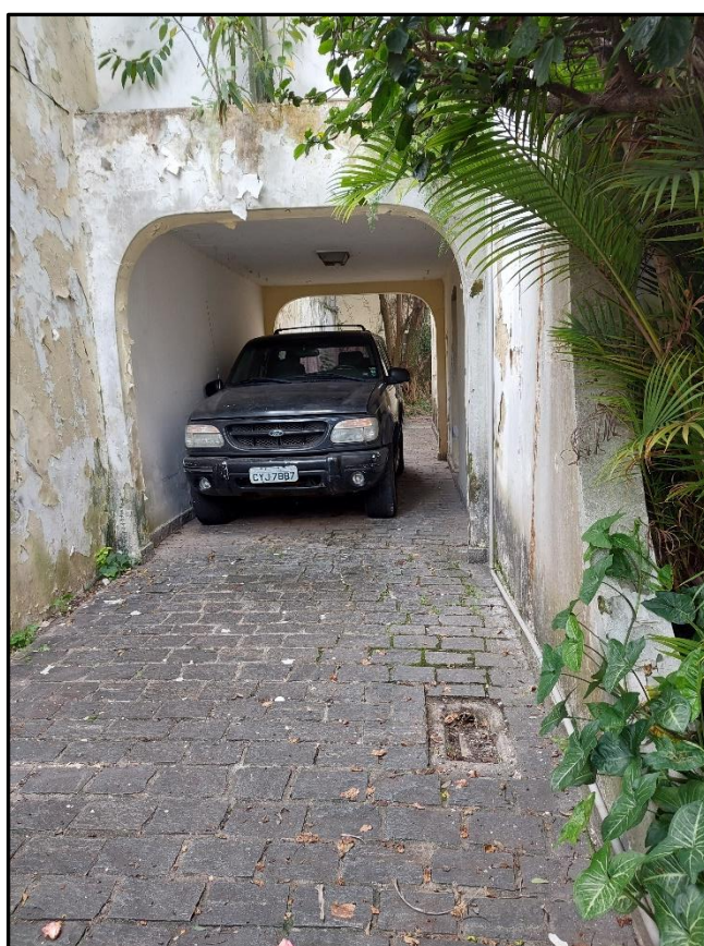
Foto 2: Entrada Principal da Residência
