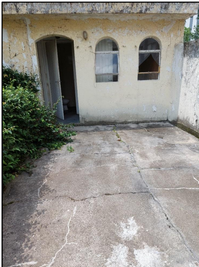
Foto 20: Vista da parte superior da Edícula pelo piso da laje
