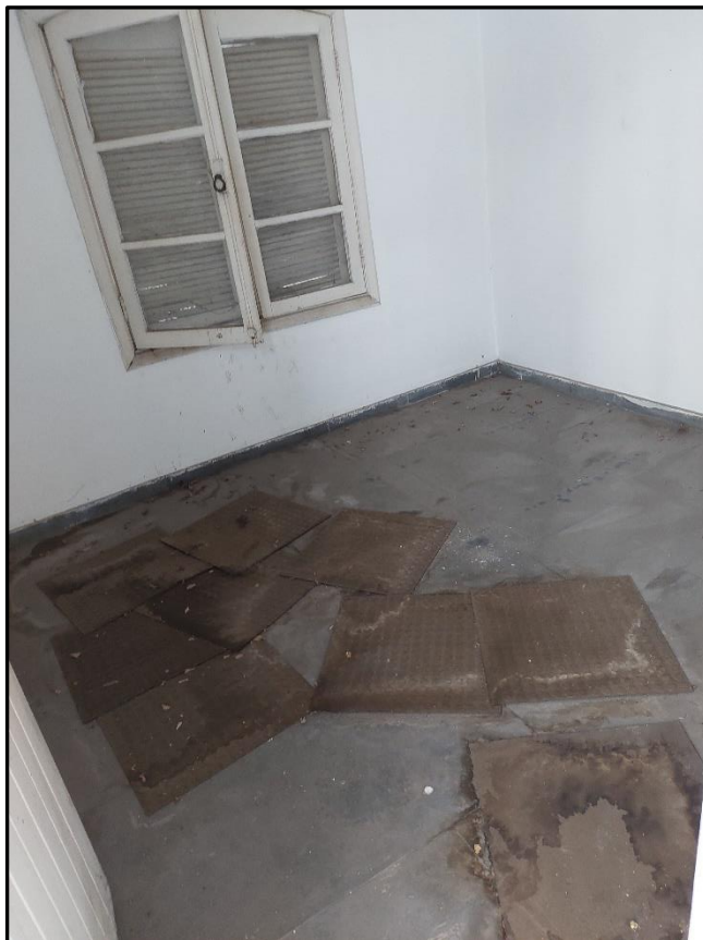
Foto 24: Dormitório para Empregada
