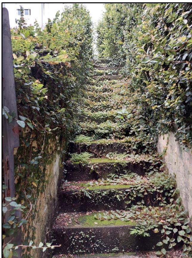
Foto 19: Escada de acesso ao piso superior da laje da Edícula
