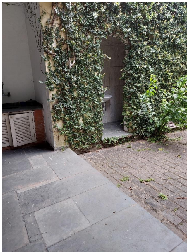
Foto 27: Entrada ao Lavatório e WC
