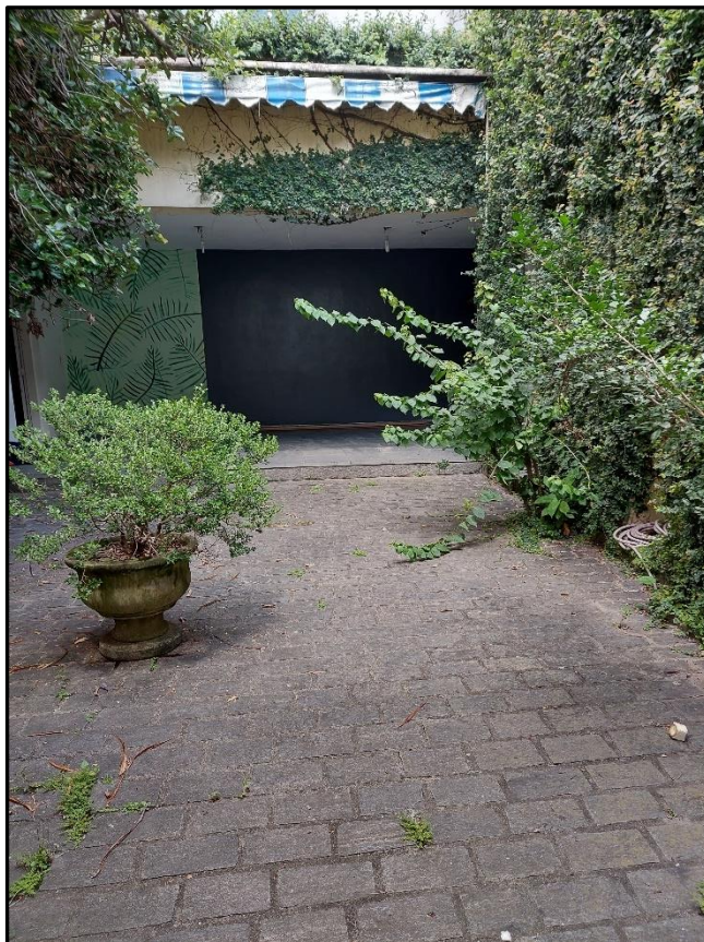
Foto 18: Vista da Edícula nos Fundos
