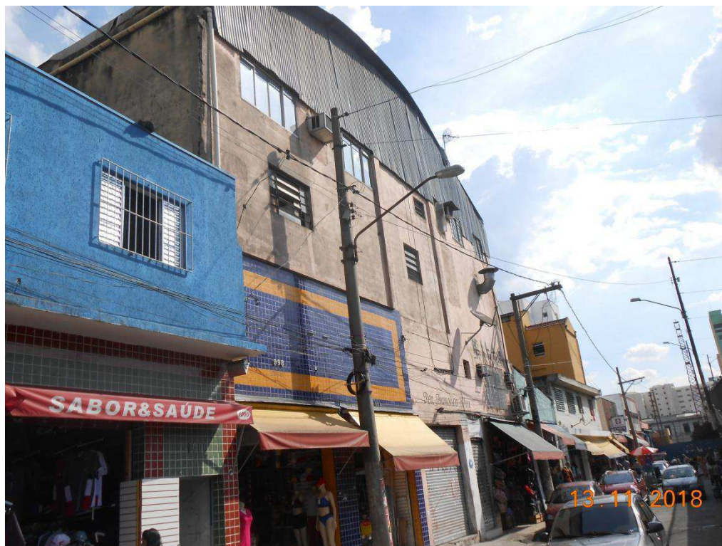
Foto 3: Fachada do imóvel na Rua do Gasômetro
