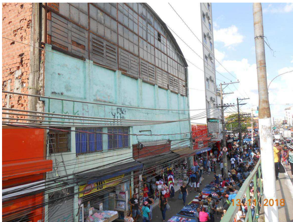
Foto 2: Fachada do imóvel na Av. Rangel Pestana
