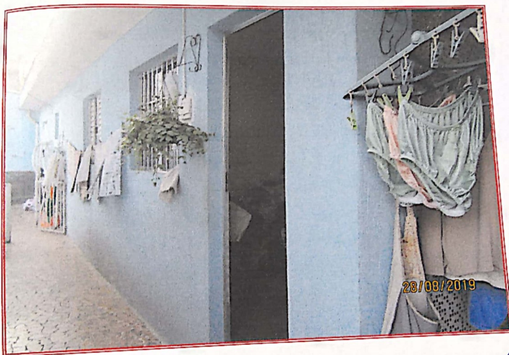
Foto nº 12: Vista geral da fachada da edícula.
