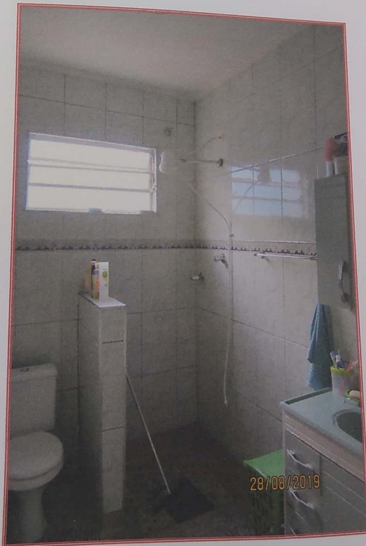
Foto nº 08: Detalhe para o banheiro.
