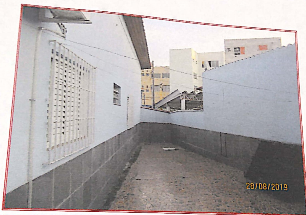
Foto nº 17: Vista parcial da área descoberta lateral.
