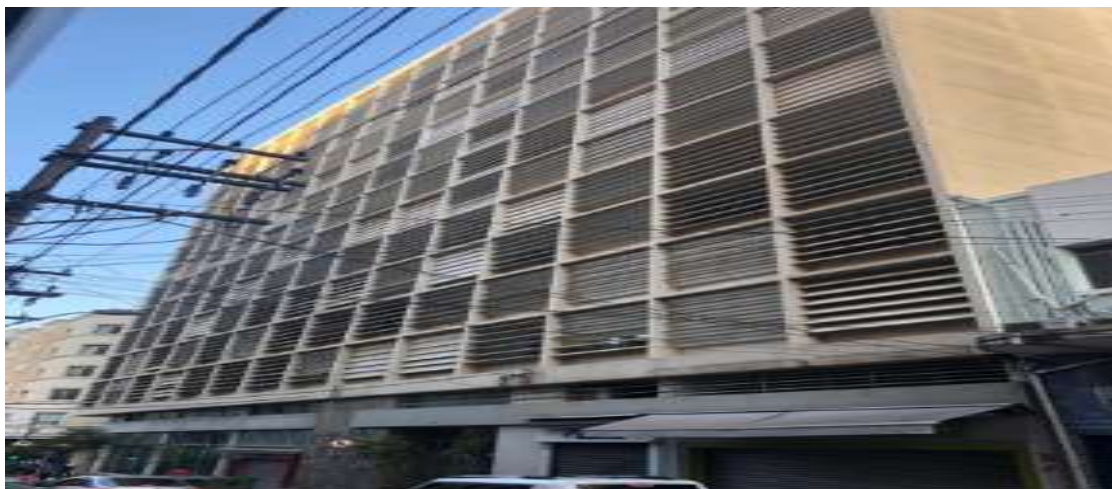
Fachada do prédio
