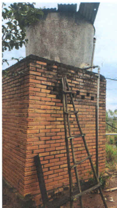
Fotografia 3. Detalhe de caixa de água em uso.
