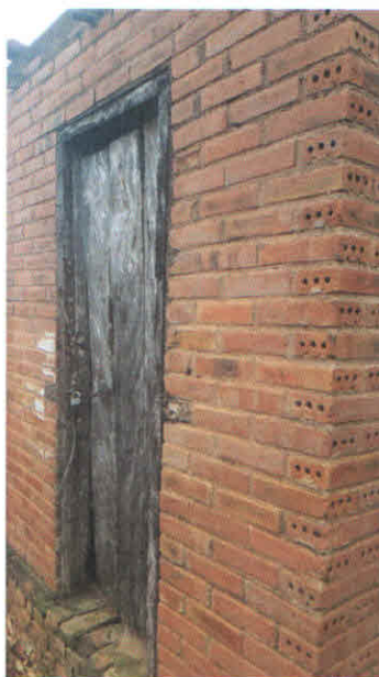
Fotografia 2. Base para reservatório de água em alvenaria.
