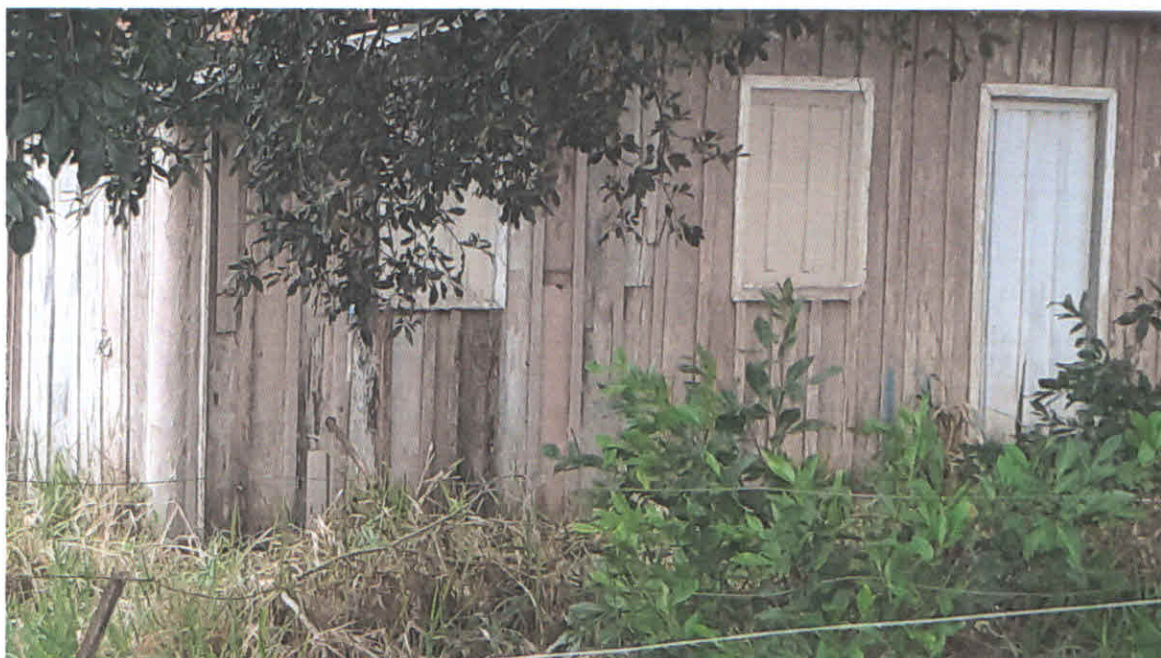
Fotografia 8. Vista externa do madeiramento da casa de funcionário.
