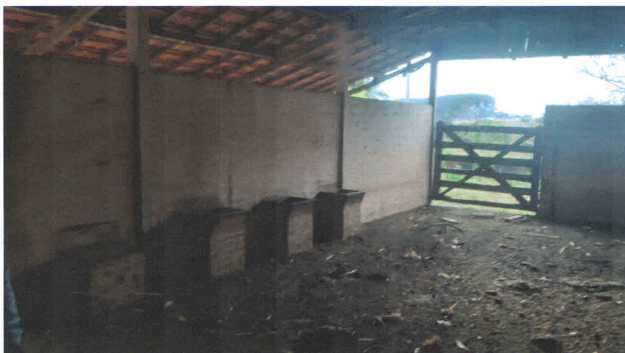
Fotografia 13. Vista do interior do barracão, utilizada para ordenha Sistema Espinha de Peixe.
