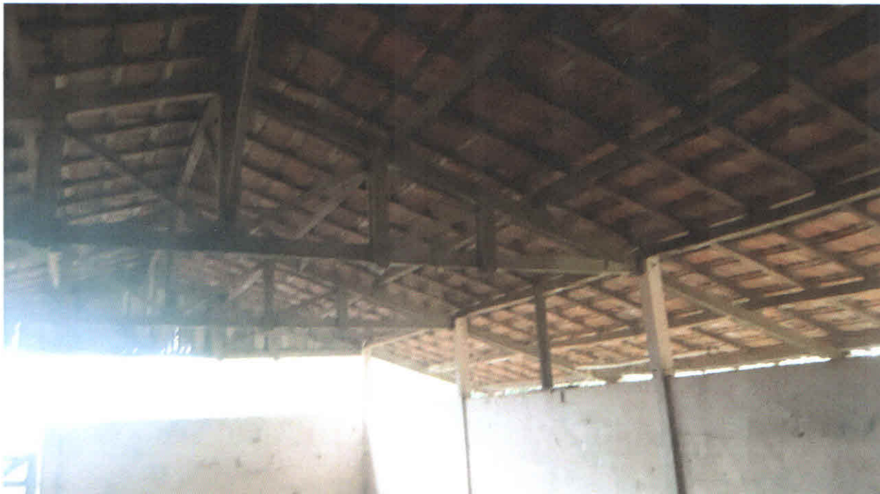
Fotografia 10. Vista do madeiramento em boas condições
