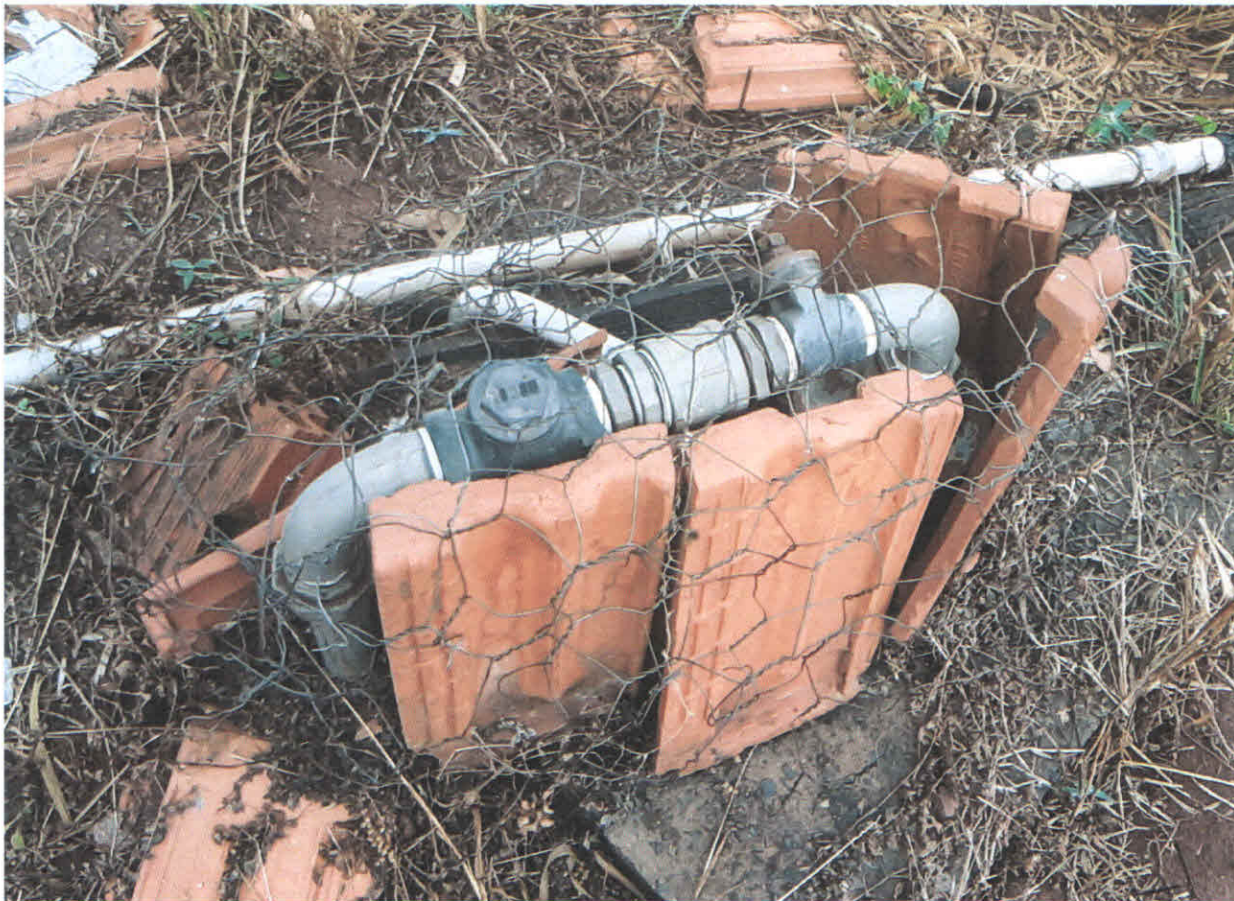
Fotografia 1. Imagem da saída do poço
