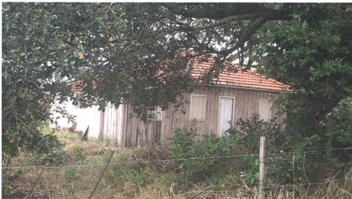
Fotografia 7. Vista externa da casa de funcionário.
