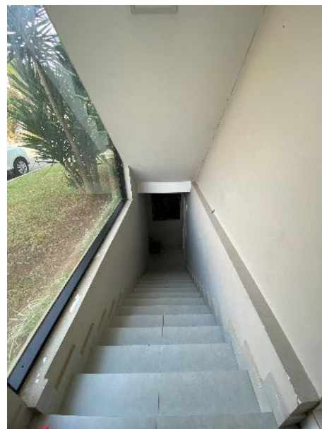
ACESSO À ÁREA DE LAZER NO SUBSOLO
