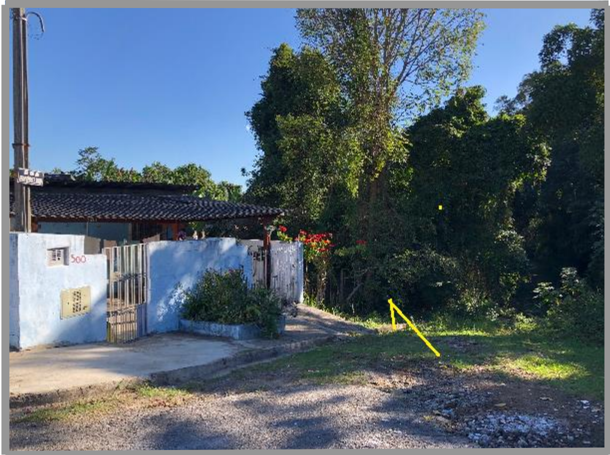
Vista complementar da área avalianda, face principal .
