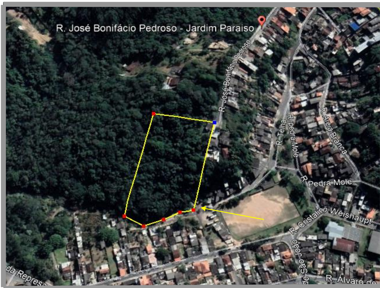
Vista global da área, detalhe do aceso pela Rua Telha.
